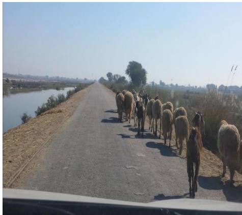
良いコンディションの道路 シカルプール (SH-52)
