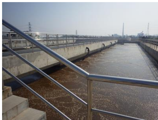
南区下水処理場のエアレーションタンク (改良型 A 2 O 法を実施)
