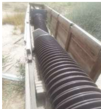
ダドゥ変電所敷地内 198kV サージ 避雷器 (NTDC 提供)
