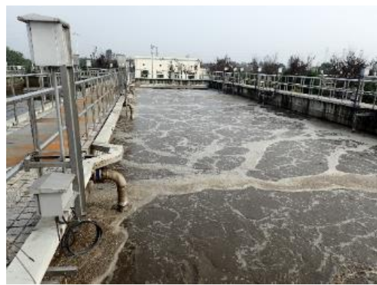
綿陽市松並処理場
