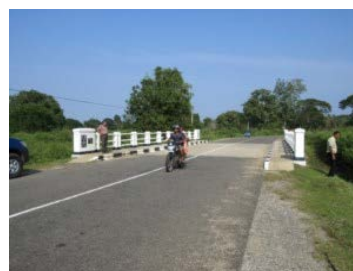
架替え後のプラバディ橋 (No.3 橋梁)
