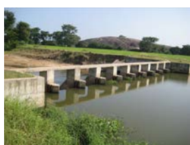
東部州アンパラ県の灌漑 用ダム施設 (Sagama Irrigation Scheme)
