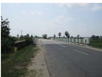
架替え後のチェンカラディ橋 (No.4 橋梁)
