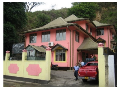
本事業で改築を行った 中部州道路開発局本部事務所
