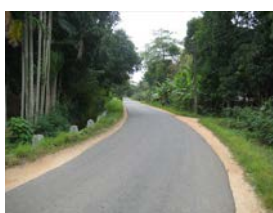
北中部州ポロンナルワ県の 州道 (D1 North Channel Band Road)
