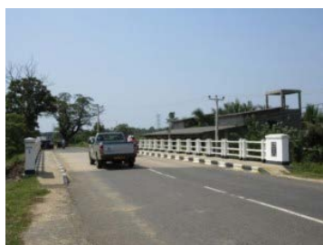
架替え後のマハオヤ・アツガンガ橋 (No.1 橋梁)
