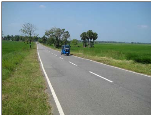
本事業により復旧した東部州アンバラ県の国道 (Deegavapi Temple Road)
