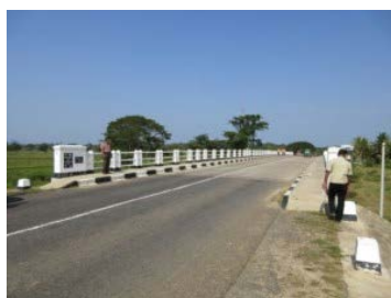
架替え後のムンデニー橋 (No.2 橋梁)
