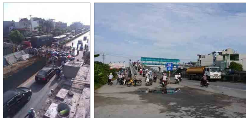
事業実施前(左)と本事業で歩道橋を実施した後(右)の道路状況
