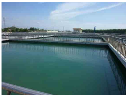
写真 1：ドンナイ省で建設された浄水処理施設
