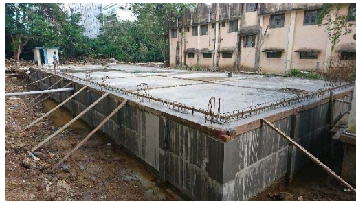
2017年12月2日天端コンクリート打設
