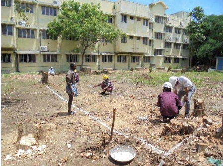
2017年9月12日墨出し作業
