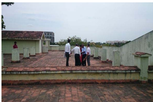
集水面の調査 (SG&SWRDC 屋上)
