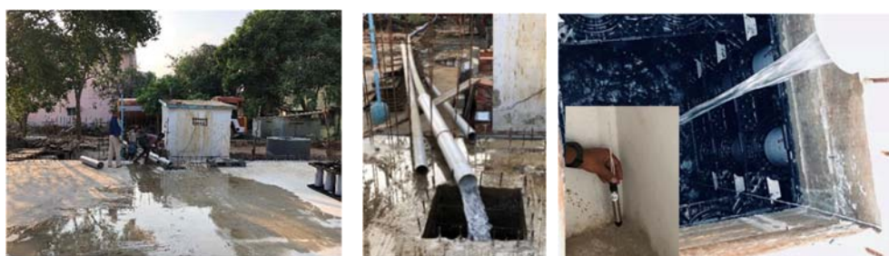
図 3-12 漏水試験の状況と水位計及び気圧計の設置状況
