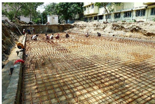
2017年10月6日基礎コンクリート配筋工
