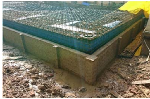
2017年11月 レンガ外壁立上げ
