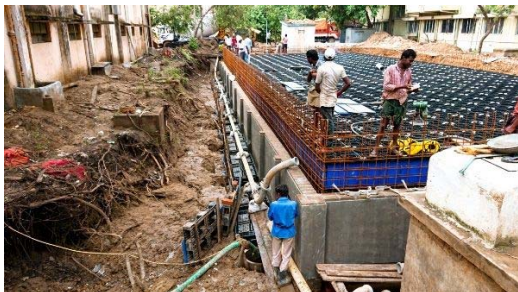
2017年11月15日側壁コンクリート打設
