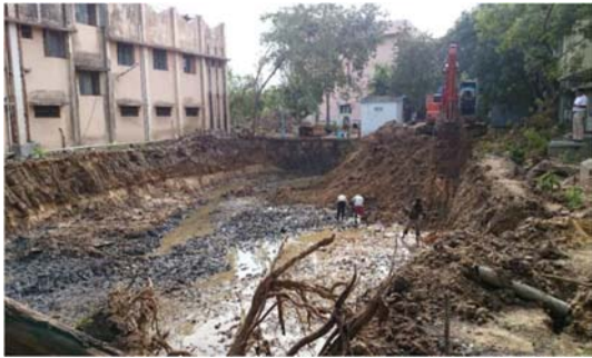
2017年9月15日掘削工
