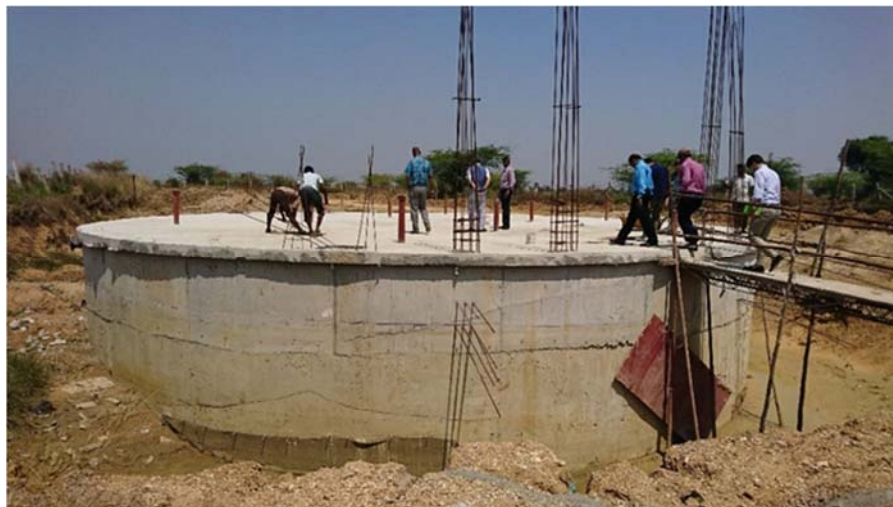
図 4-1 コンクリート製地下貯留槽の例
