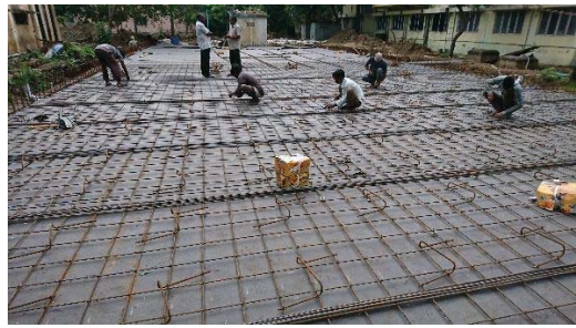
2017年12月1日天端コンクリート配筋工
