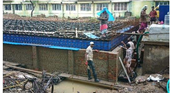
2017年10月30日外側型枠レンガ工
