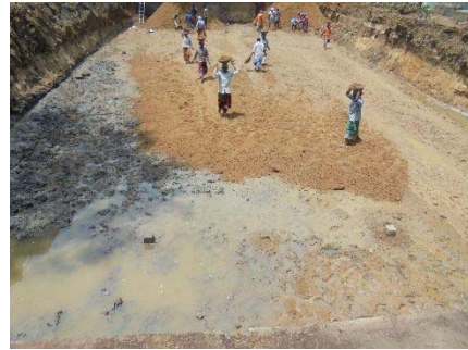
2017年9月21日敷き砂工
