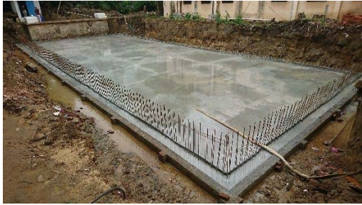
2017年10月12日基礎コンクリート打設
