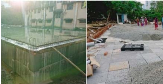
2017年12月 砕石敷き均し/ 側壁および頂版スラブ打設
