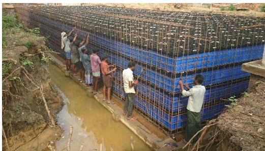
2017年10月28日側壁配筋工
