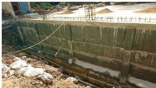
2018年1月14日止水セメント工
