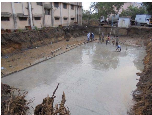
2017年9月25日均しコンクリート打設
