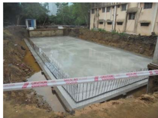
2017年10月 側壁下部配筋および底盤コンクリート
