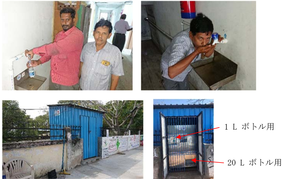
図 3-26 水栓及び Water ATM の設置状況
