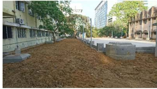
2018年1月 漏水試験合格・埋戻し完了
