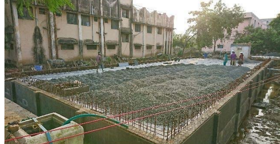
2017年11月28日天端砕石敷均し工
