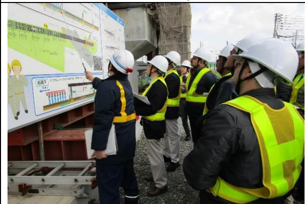
22-Jan JR TT, Shinkansen Work Site
