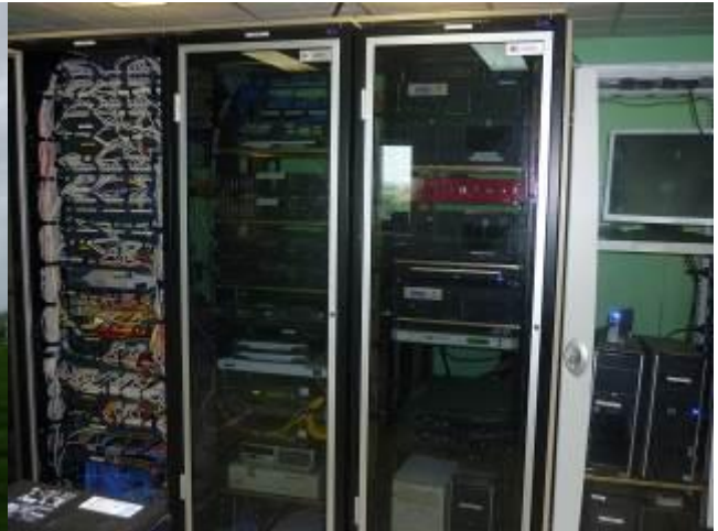
⑥ Fiji 気象局 受信サーバー設置希望場所 信号受信サーバーは、サーバールームのラックへ、1 U タイプ PC での設置を希望。
