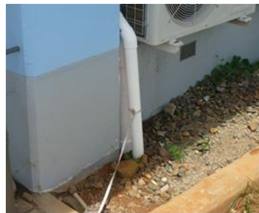
(d) 建屋へのケーブル導入部
