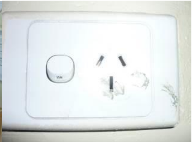
⑧ Solomon 気象局 電源プラグ 電源プラグは O タイプ。瞬断も含め停電が多いため、殆どすべての PC は、簡易 UPS を経由して接続されている。
