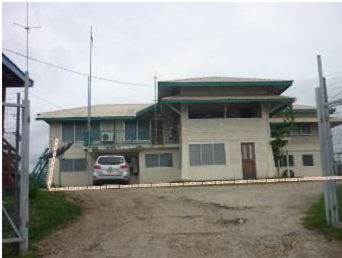
(c) 右図の草地から、パンザマストの横を経由し、駐車場脇をとおり、2階の予報官室（赤○）への導入を希望
