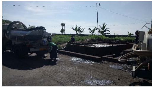
写真 4.1.3 バキュームトラックによる既存処理場への汚泥搬入の様子
