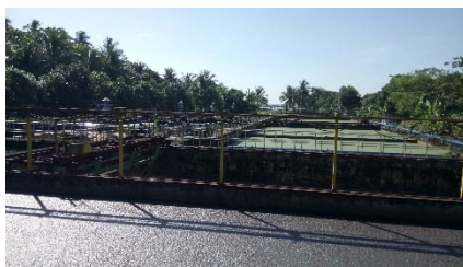
写真 4.1.1 既存下水処理場
