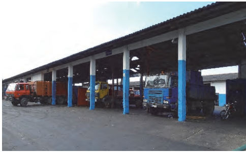
UPPH 中央車両整備場：4棟のうちの1棟
