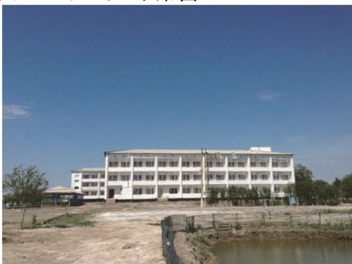
女性精神障害者施設外観 (ヌクス市内から車で30分)
