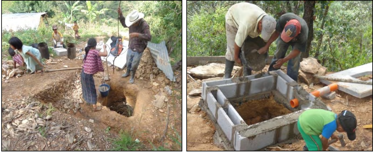
トイレ設置作業の様子（働いているのは全員がコミュニティの住民）
