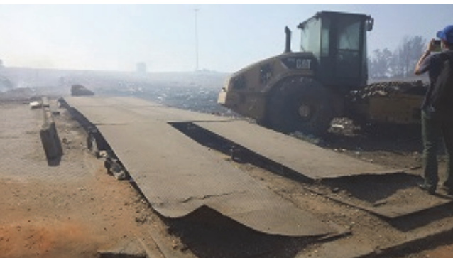
故障したトラックスケール (フレネ最終処分場)
