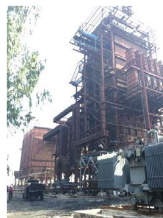
A 社 発電設備の外観
