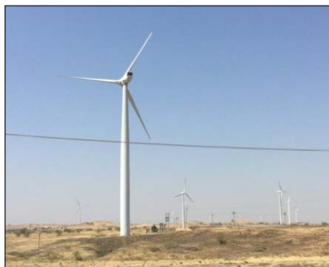
本事業融資対象の風力発電所
