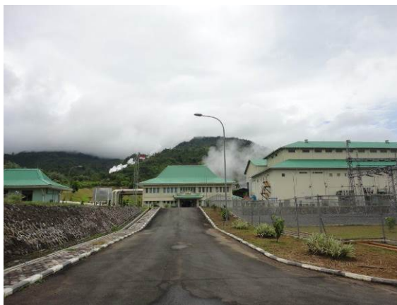
ウルブル地熱発電所（外観）
