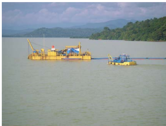
ビリビリ・ダム貯水池取水口付近の浚渫作業
