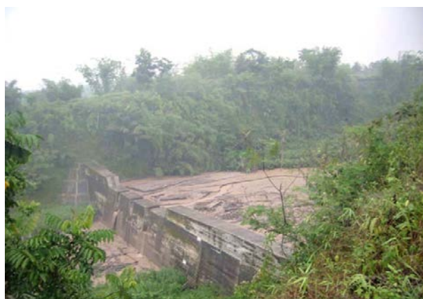
クラサク川で土石流捕捉後の砂防堰堤 (出所：実施機関提供資料)
