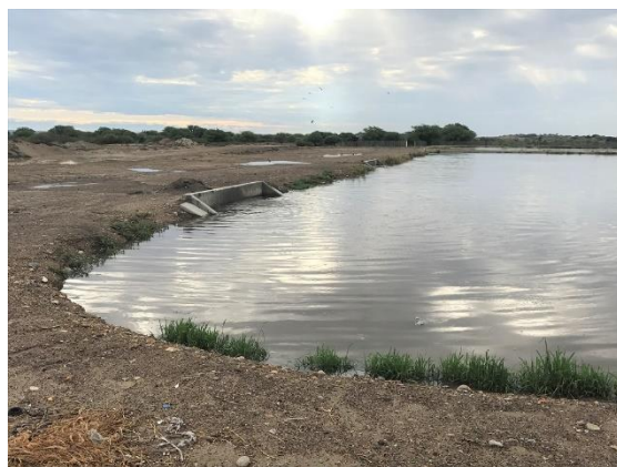
El Indio STP (Piura)
