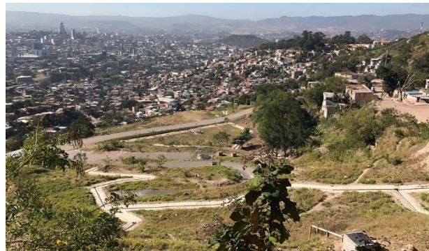
エル・レパルト地区の全景（対策後）
