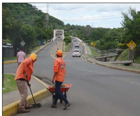
テコロストーテ橋付近で清掃作業を行うFOMVの作業員
