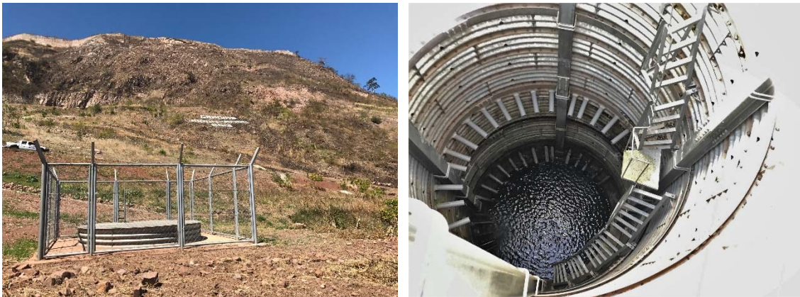
エル・ベリンチェ地区の集水井とその内部（扇状に配置された集水ボーリング工が見える）
