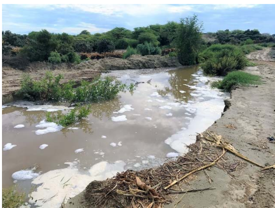
エルインディオ下水処理場の放流路延長部分 (ピウラ市)
