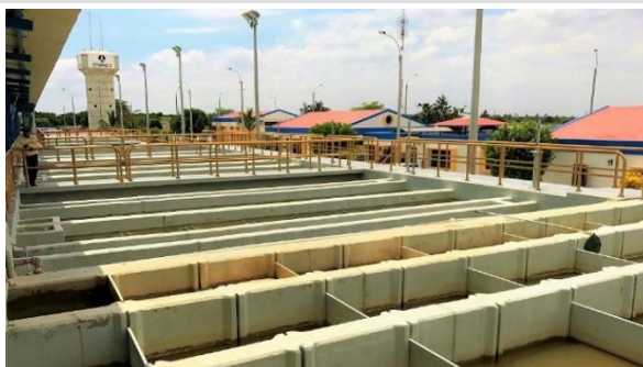
ピウラ市浄水場
