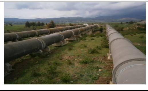
本事業により三重化された導水管（メジェルダ川沿い）（2017年4月撮影）
