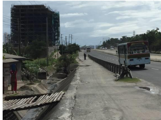
写真2 沿道に建設中の近代的なビル
