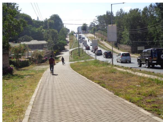
接続された7号線の一部
