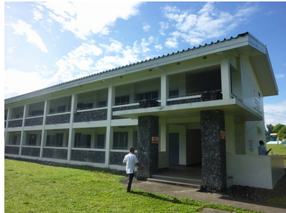
本事業で整備された学校兼避難所施設 (サントドミンゴ中央小学校)
