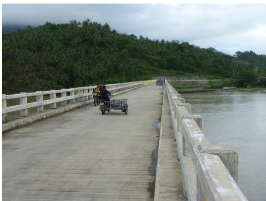
写真 3：ウミライ橋の道路表面
