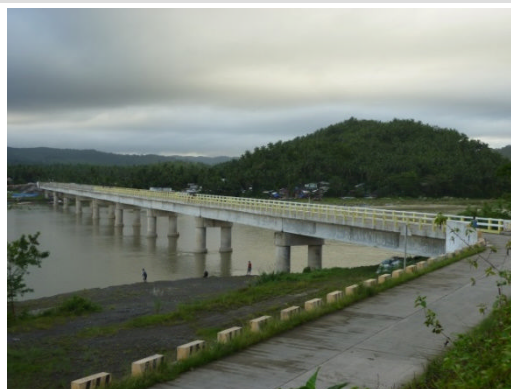
建設されたウミライ橋及びアクセス道路
