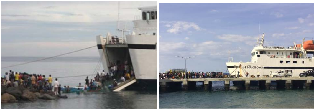
写真：オエクシ港改修前（左）と改修後（右）のフェリー乗降時の様子
