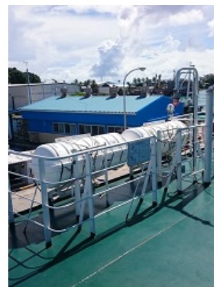
写真 2 船内に設置された膨張式救命筏
