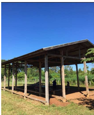
本事業実施後に建築したコミュニティの 会議場（ラオンガム郡パコートニャイ小学校）
