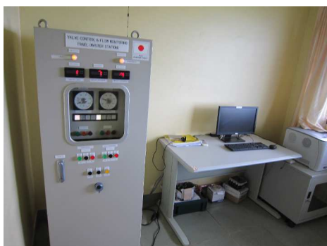
配水量監視システム（左）と配水量を測定するメータ（右）
