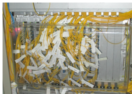
事後評価時：ラベルが付されており、必要に応じて束ねられているため、ケーブルの行き先が一目でわかる。 (写真：外部評価者撮影)
