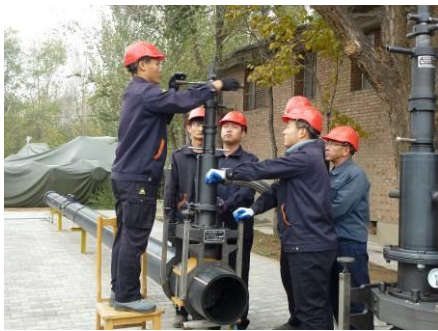
研修所でのガス管交換工事实演
