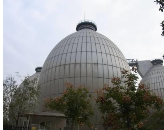
袁楽村下水処理場の汚泥消化槽
