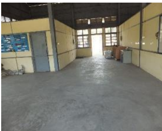
Workshop 内部間仕切り壁
