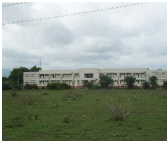
道路反対側敷地のホステル2棟(完成)
