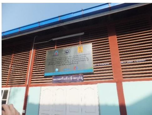
改修された溶接科のワークショップ
