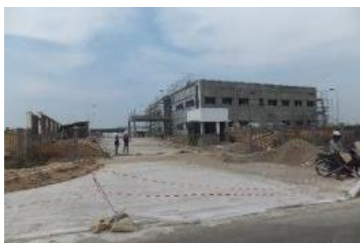
建設中の職業訓練センター：RC造
