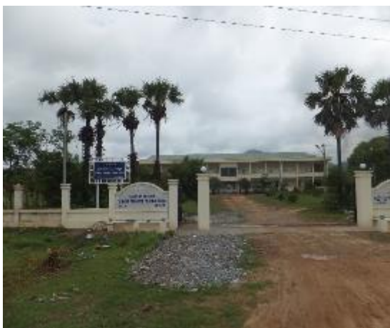
TPTC ゲートと管理棟
