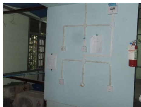
電気配線工事訓練用パネル
