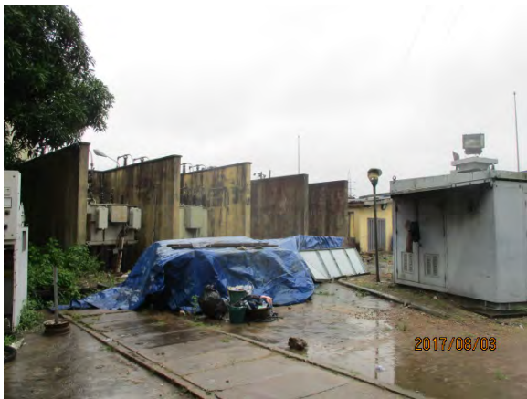
アパパロード変電所（建屋、132/33kV変圧器予定地）
