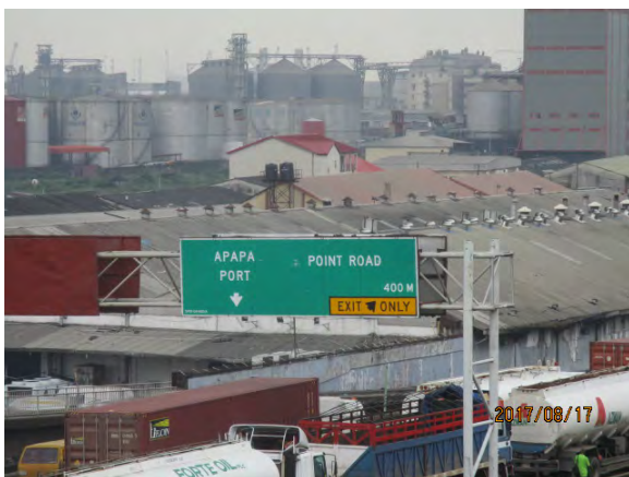
アパパロード変電所周辺の様子
