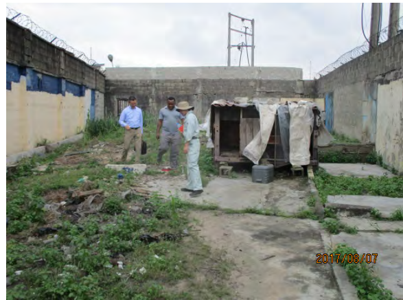
アパパロード変電所（接地変圧器予定地）
