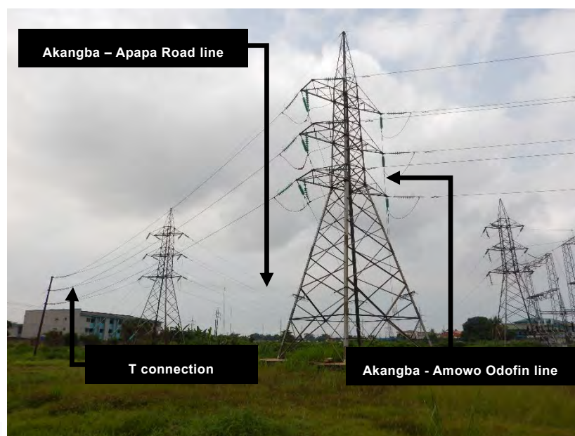
図 2-1-4 アカンバ変電所での1回線T分岐
