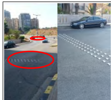
写真 曲線部のチャッターバー設置
