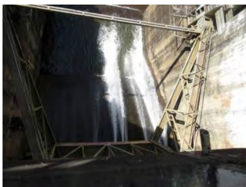
図 7-23 洪水吐ラジアルゲートからの漏水状況
