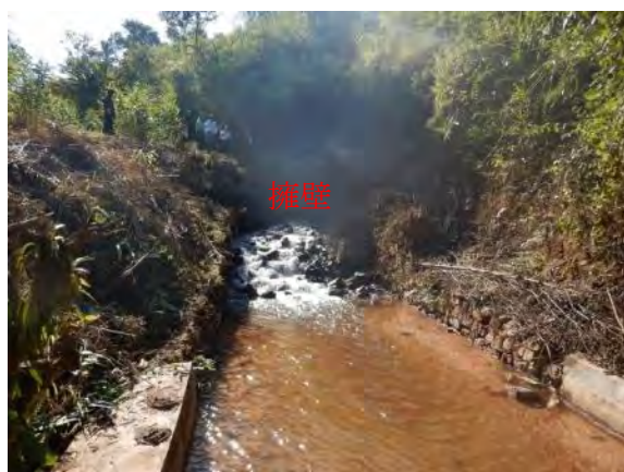
発電所運転時状況
