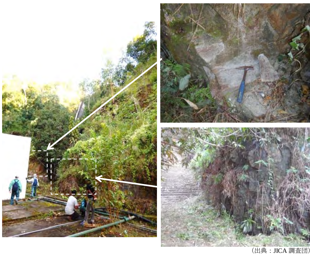
図 7-18 鉄管路沿いでの露頭（硬質な片麻岩）
