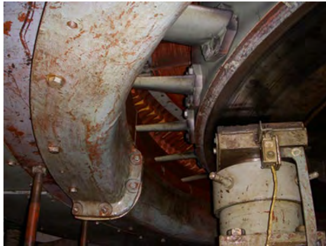
図 7-7 ブレーキと回転子磁極
