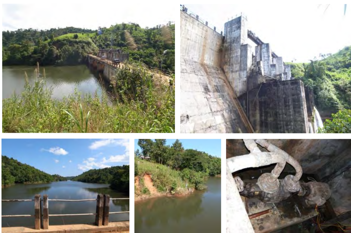
左上より時計周りで、ダム上流面、ダム下流面、ダム上流景色、 量水標杭、監査廊内排水ポンプ
