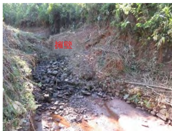
水路排水時状況
