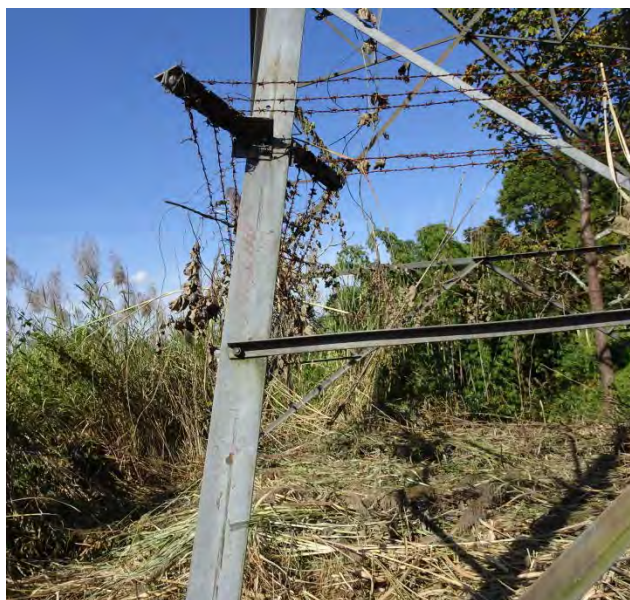
図 8-7 最下設部材の劣化状況 (Umiam Umtru Stage III 発電所 - Umtru 発電所 送電線)
