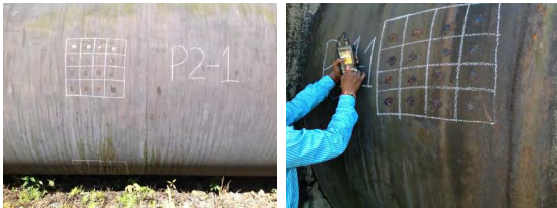
図 7-36 水圧鉄管板厚測定状況
