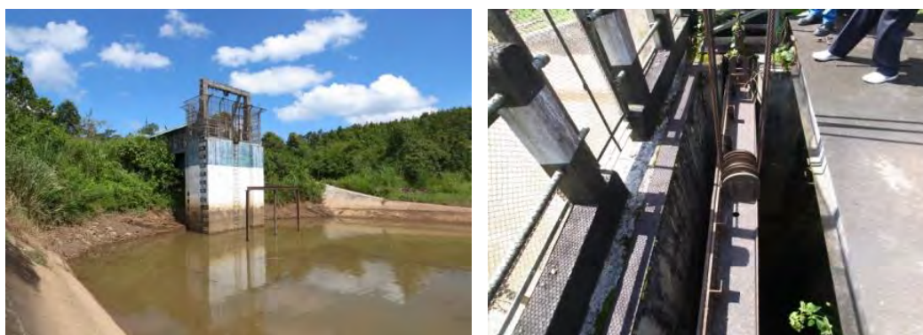
図 7-24 リンクトンネル取水口と取水ゲート
