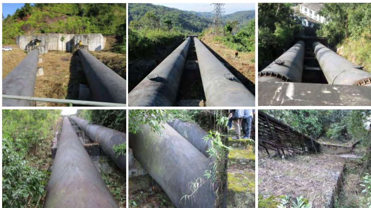
左上より時計周りで、アンカーブロック 2 から上流、アンカーブロック No.2 から下流、アンカーブロック No.3 から下流、下部埋設管部の上流、下部埋設管部始点、下部埋設管部
