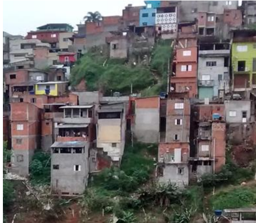
Figura 51: Vista de edificações multipavimentos em área de risco (Foto: Andrade, 2015).
