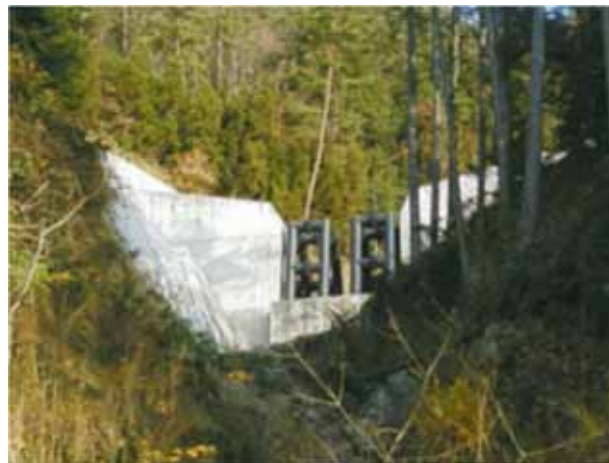
Foto 4. Barragens Sabo Semi-Permeáveis
