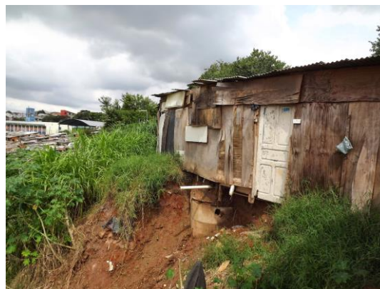
Figura 53: Vazamento de fossa em talude.
