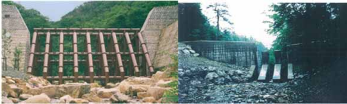
Foto 5. Exemplos de barragens Sabô permeáveis para bloquear o fluxo de detritos.
