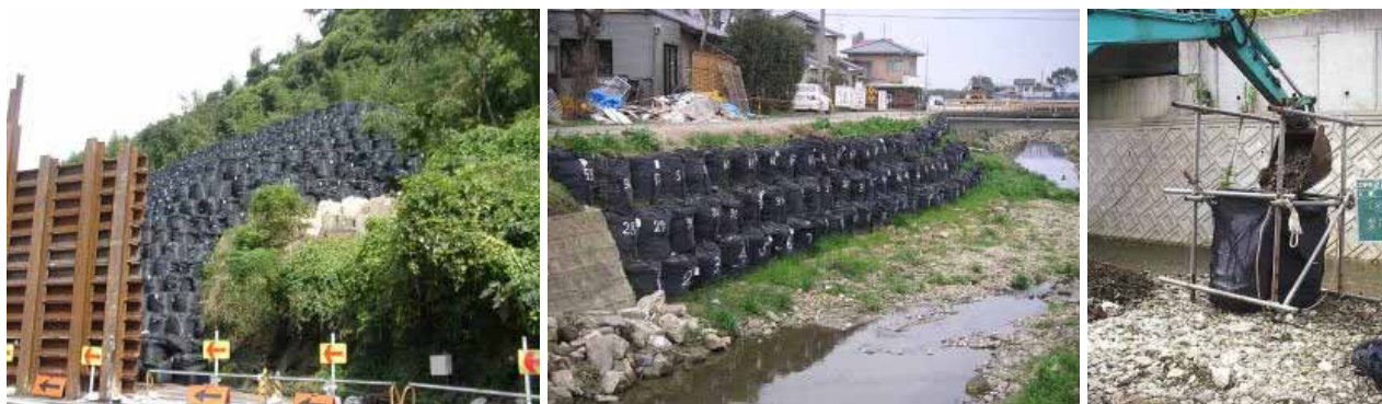
Fig.10.2: Obras de Empilhamento de Sacos de Areia de Grande Porte, Piquetes / Placas de Aço
