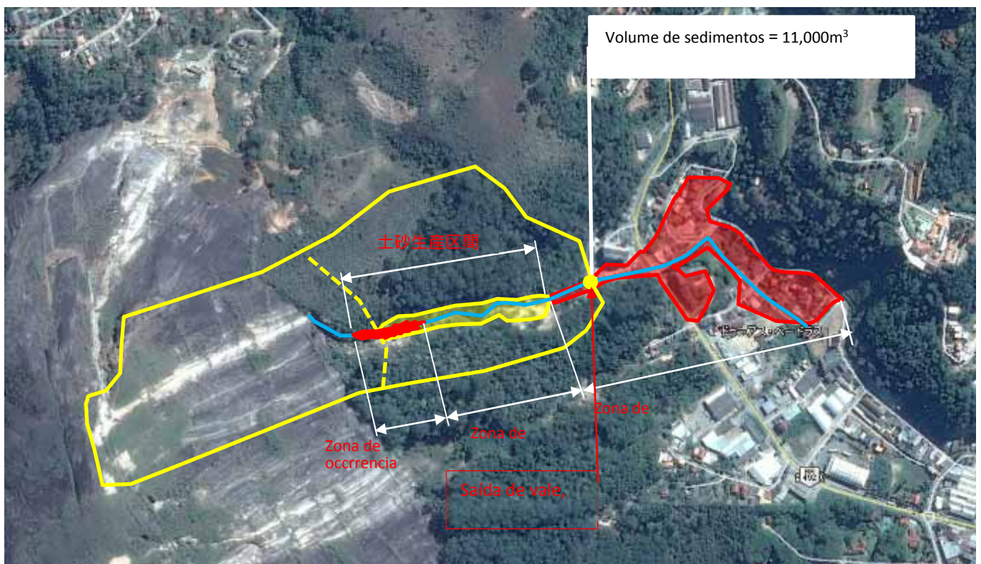
Figura 20. Assunção de fenômeno do fluxo de detritos
