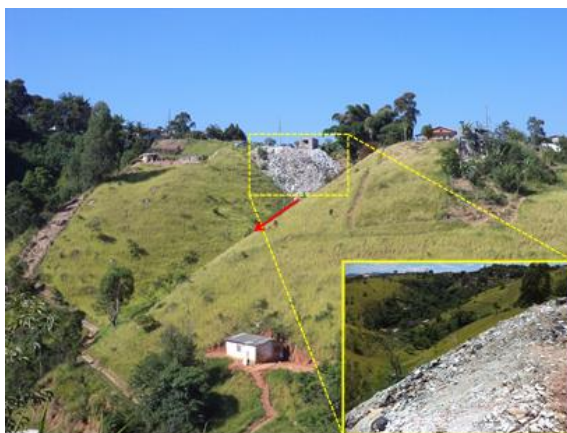
Figura 534: Depósito de resíduos em encosta íngreme (Foto: Mendes, 2014).
