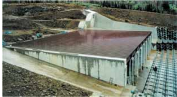
Foto 3. Barragem Sabo tipo Permeável
