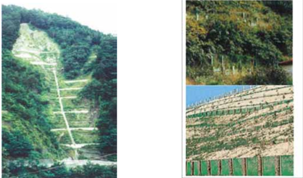
Foto 1. Muros de contenção e drenagens superficiais.
