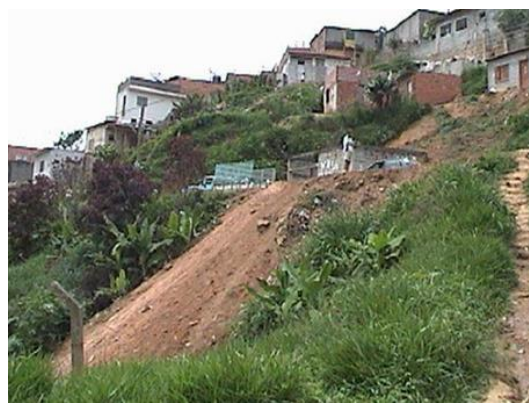
Figura 49: Vista de aterro lançado em encosta de área de risco (Foto: Oliveira, 2005).
