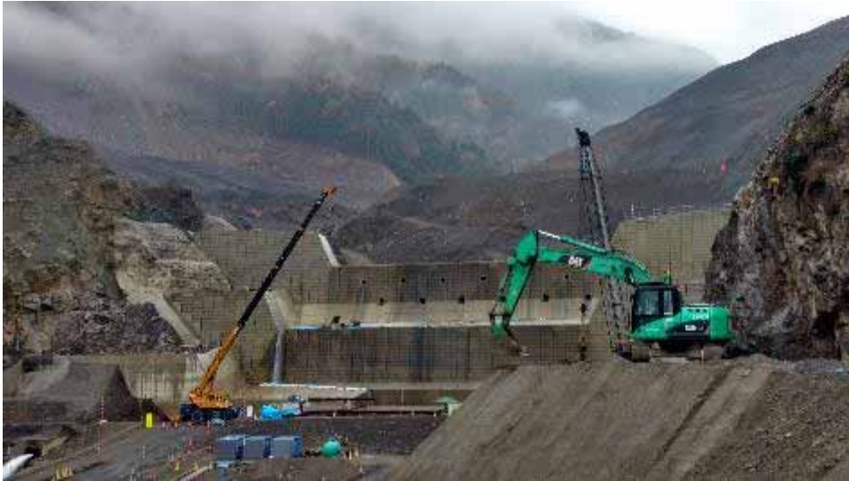
Foto 2. Exemplo de Barragem Sabo Impermeável
