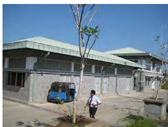
事務所棟（コッタワ料金所）
