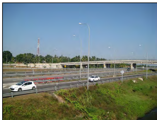
南部高速道路（コッタワ IC 付近）
