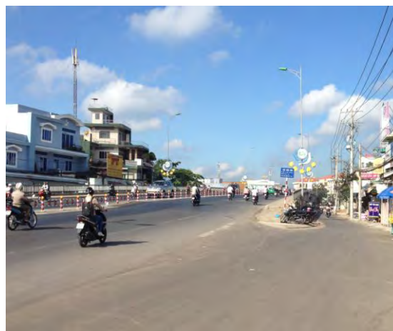
カイラン橋の様子
