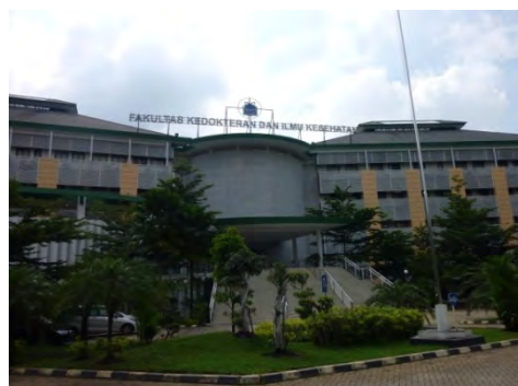
本事業で整備された FKIK 校舎
