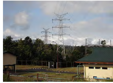
PLN が設置した送電塔 2 基
