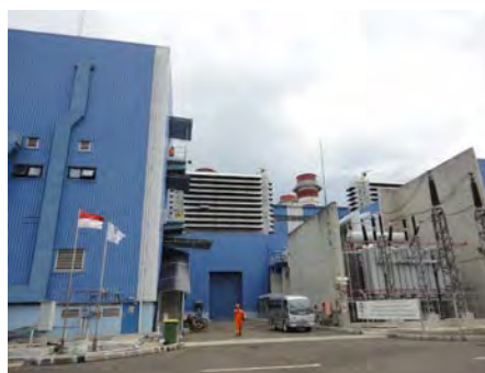
タンジュンプリオクガス火力発電所(ブロック3)
