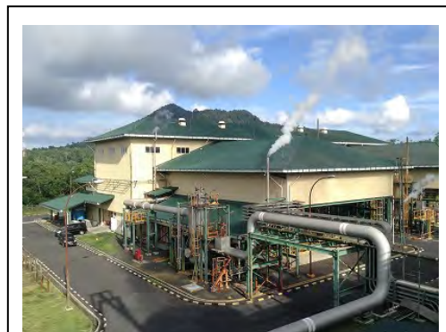
ラヘンドン地熱発電所（外観）
