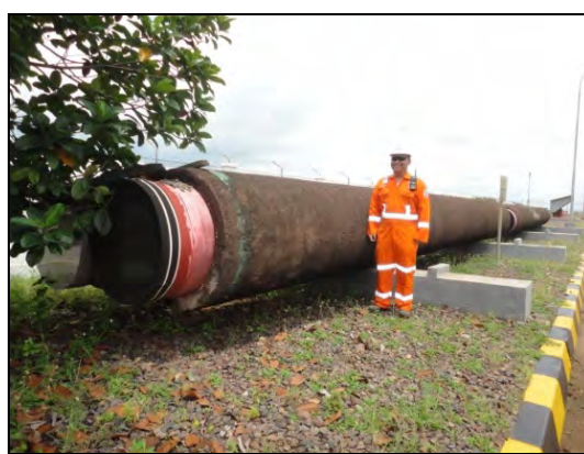
スペアのパイプ（チレゴン）
