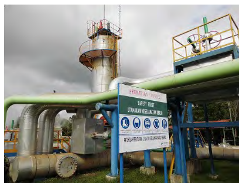
パイプライン交換箇所(23号/28号蒸気井)
