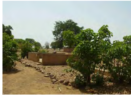
泥たまりや洗掘を避けるための井戸周りの砂利敷及び 家畜除けのための生垣（住民により整備された）
