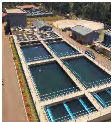
本事業で建設されたムカング浄水場
