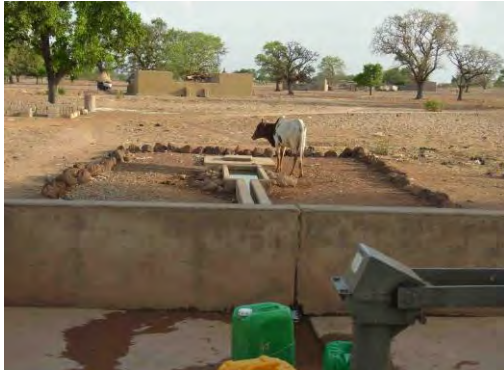
ポンプからのこぼれ水が排水路をつたい 家畜水飲み場へ流れる仕組み
