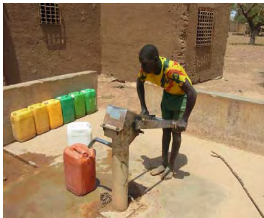
建設された人力ポンプ付深井戸給水施設
