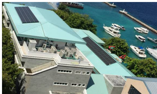
大統領府屋上の太陽電池パネル
