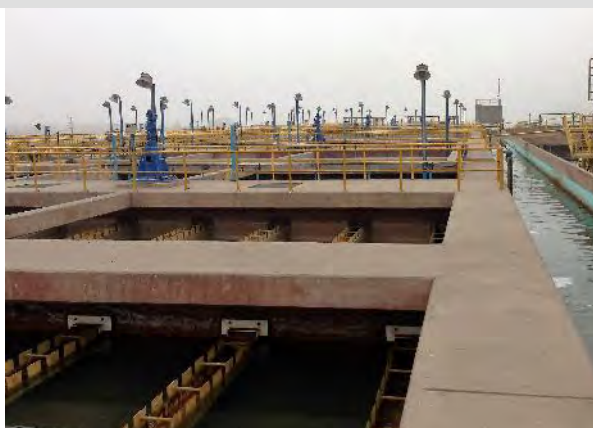
ワチパ浄水場
