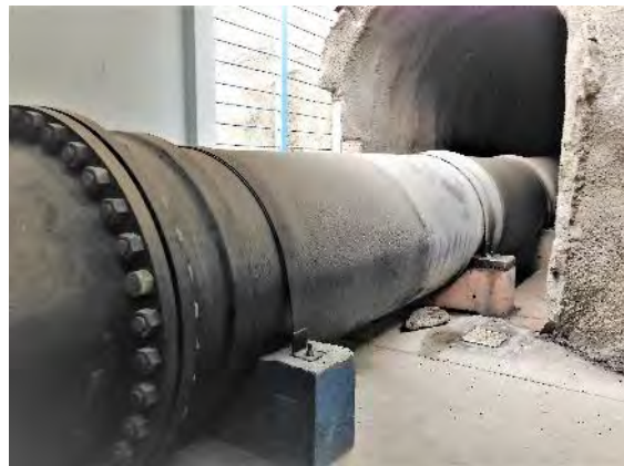
北部送水管（トンネル出口）
