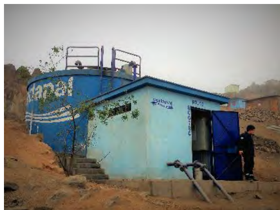
本事業で建設された貯水池
