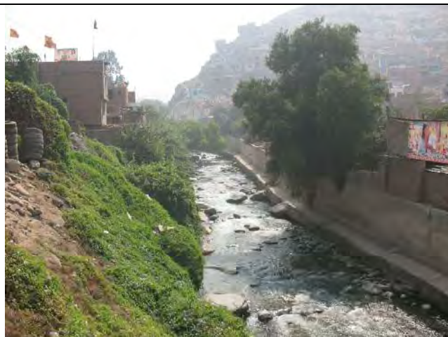
Foto 2: En la foto se puede apreciar la pared levantada en una de las márgenes del rio Rimac para evitar las inundaciones.
