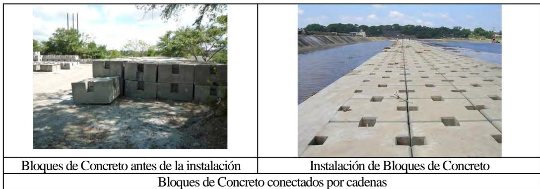
**Figura 5.4.6 Ejemplos de Bloques de Concreto instalados en aguas abajo para protección del lecho del Rio**
