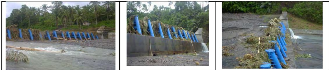
**Figura 4.3.10 Ejemplos de Slit Dam**
