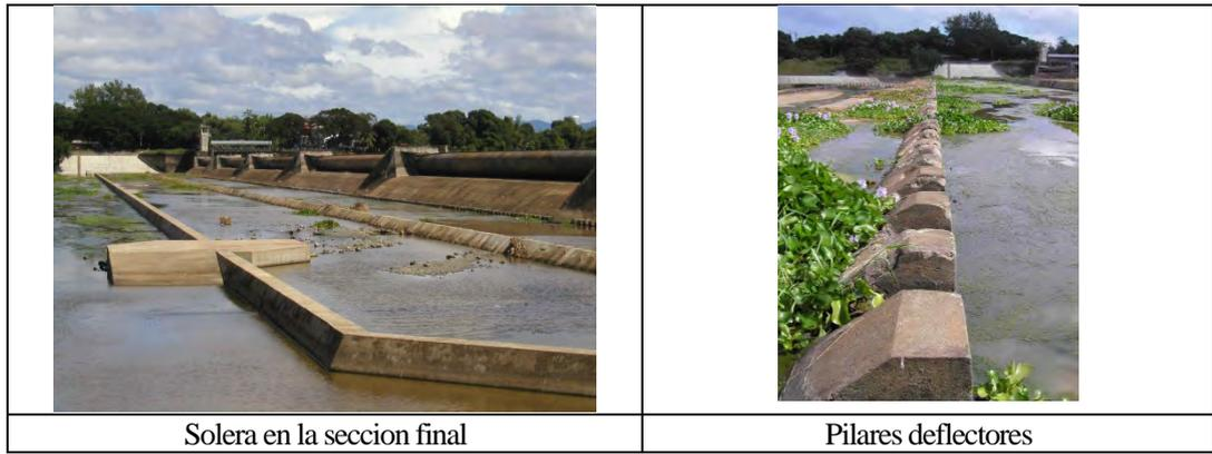
**Figura 5.4.5 Diseño de salto Hidráulico forzado por Soleras en la sección final y pilares deflectores**
