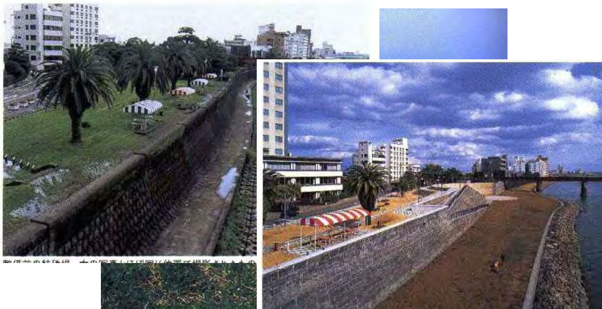
大淀大橋から下流方向を望む。特殊堤とともに、イベント広場を設置した橋公園も新
