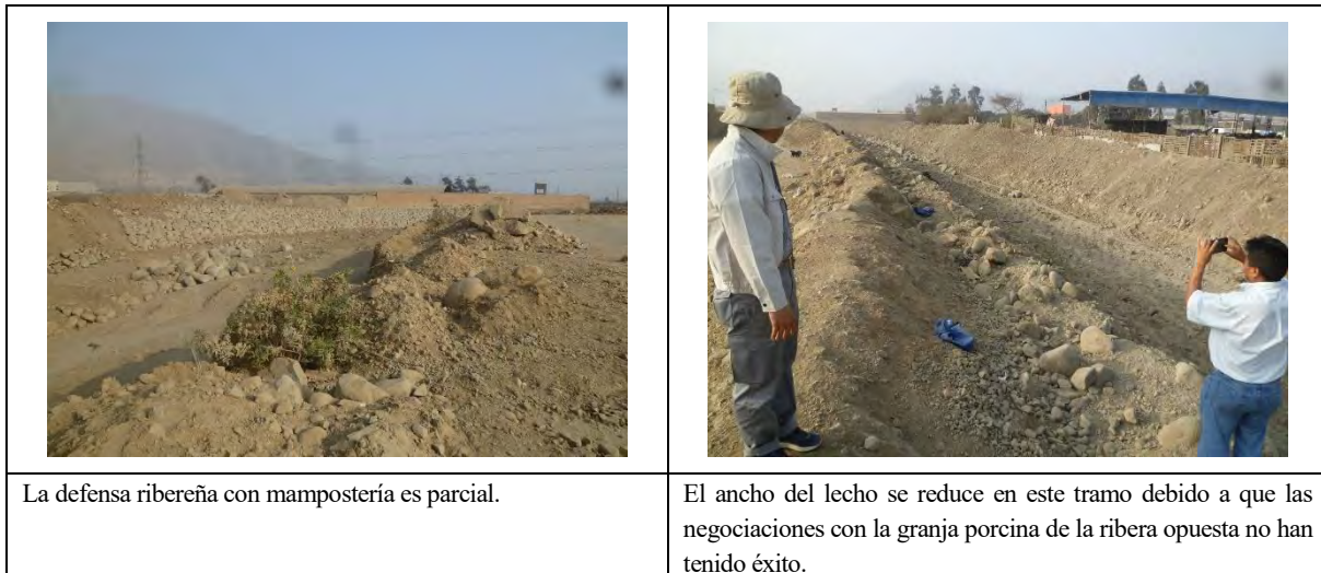
Figura 13.3.96 Condiciones de la quebrada. Huaycoloro
