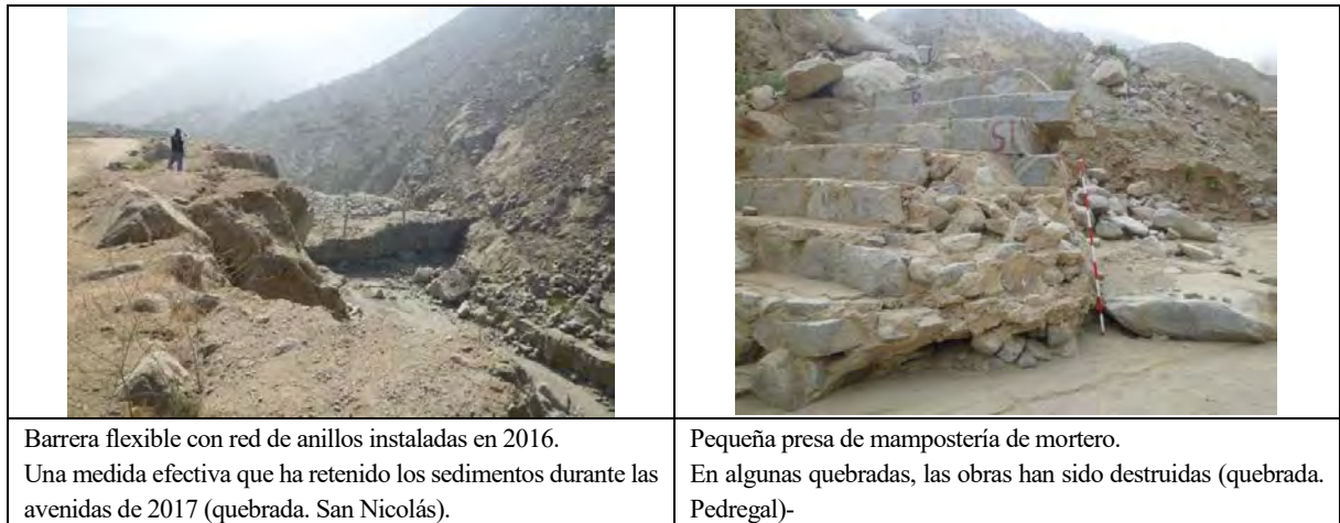
Figura 13.3.86 Ejemplo de las medidas de control de sedimentos ejecutadas por la municipalidad de Lurigancho-Chosica
