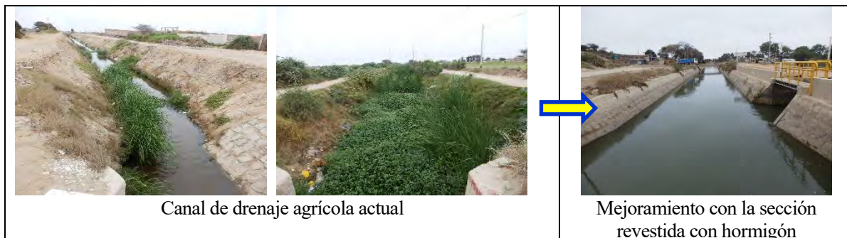
Figura 13.3.65 Mejoramiento del canal de riego existente mediante el revestimiento con hormigón
