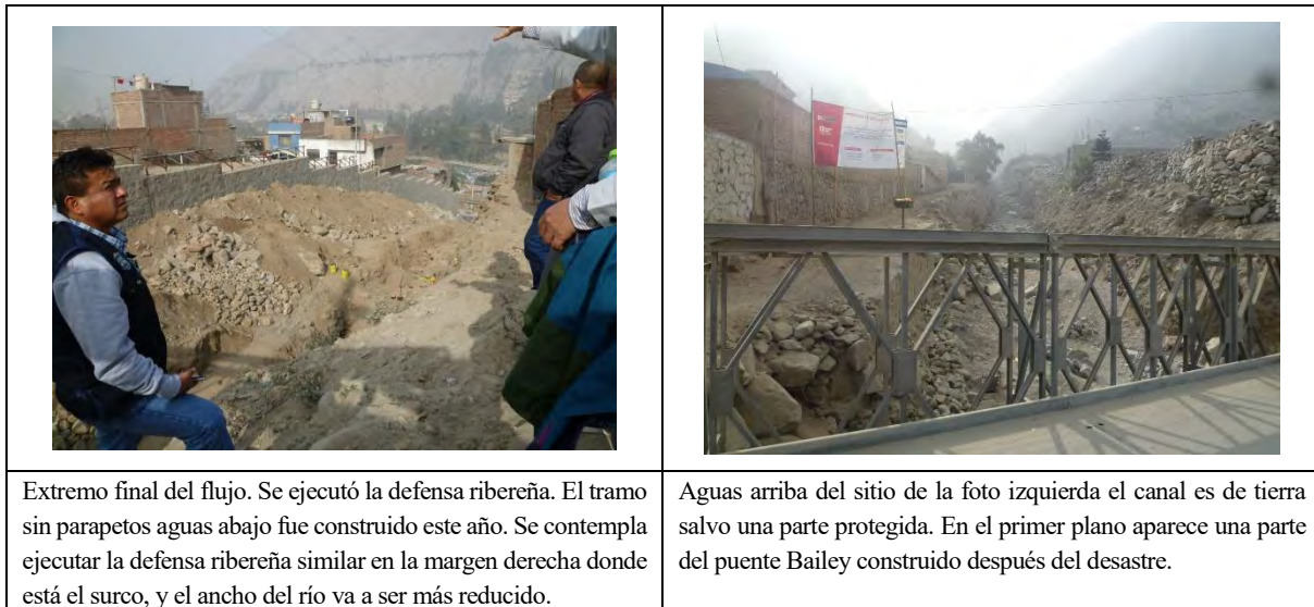
Figura 13.3.88 Condiciones actuales de la quebrada Corrales y
