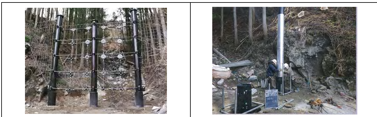
Figura 14.4.8 Urban Guard, tecnología de control de huaycos mediante postes (izquierda: estructura terminada, derecha: estructura en construcción)
