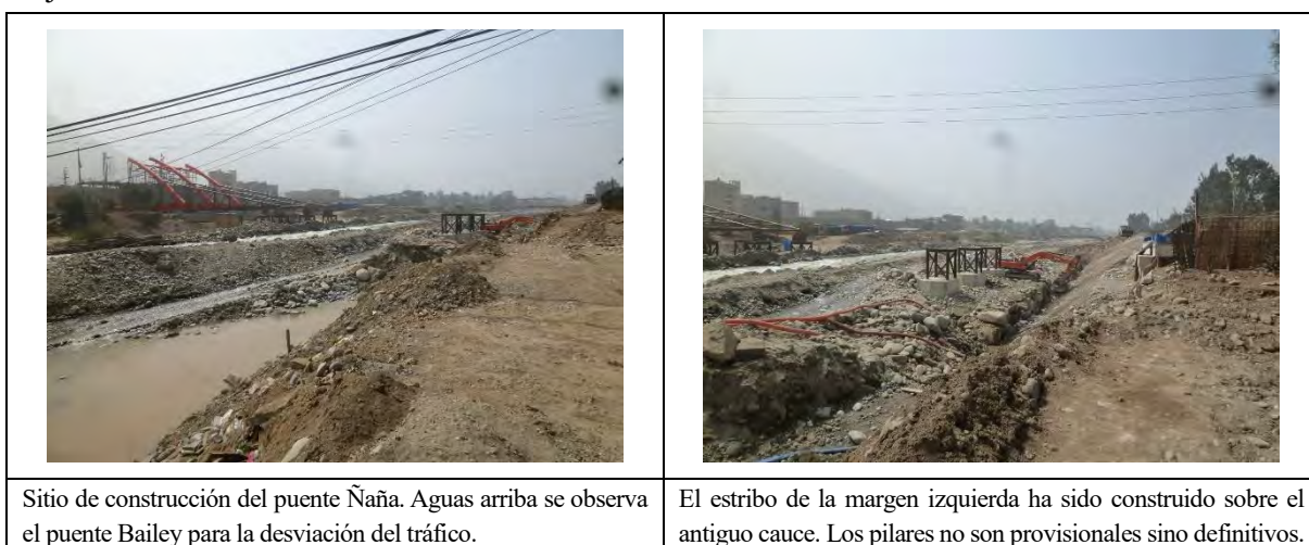
Figura 13.3.102 Condiciones del puente Ñaña
