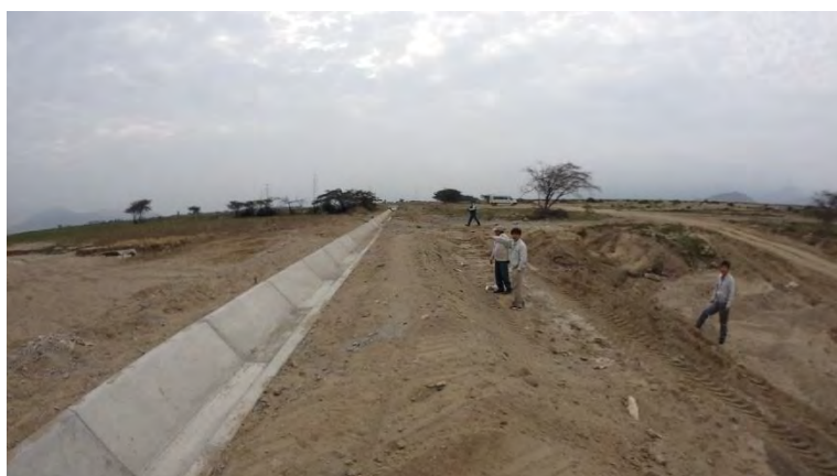
Foto: Canal de agua rehabilitada en el cruce con la quebrada. El canal intercepta totalmente la quebrada.
