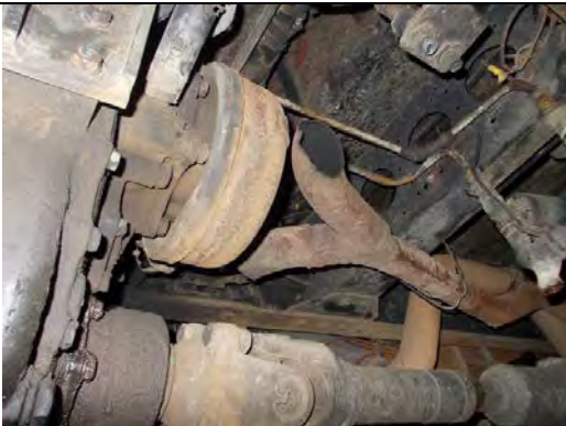
排気パイプの改造
