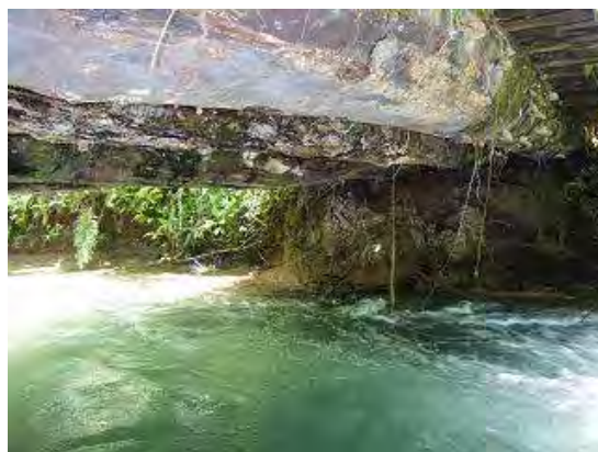
Fotografía 1a-3 Condición bajo el puente
