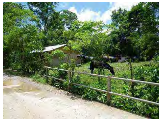
Fotografía 1a-4 Condición de pasamanos
