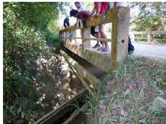
Fotografía 1a-2 Vista lateral del puente
