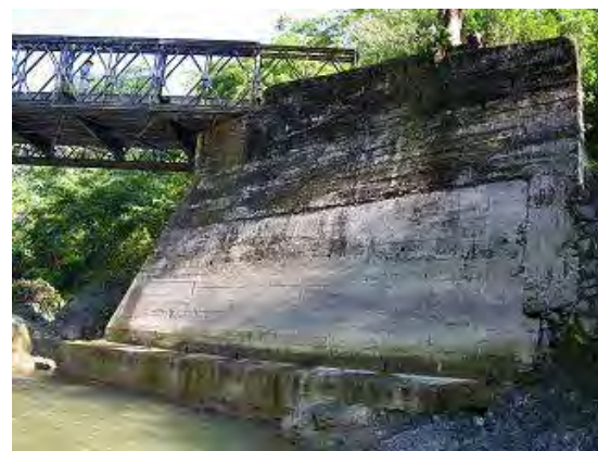
Fotografía-4 Condición del estribo
