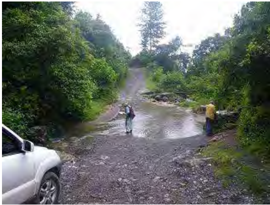
Fotografía 1a-1 Punto de cruce entre el río y la carretera
