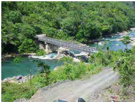
Fotografía-1 Vista panorámica del puente
