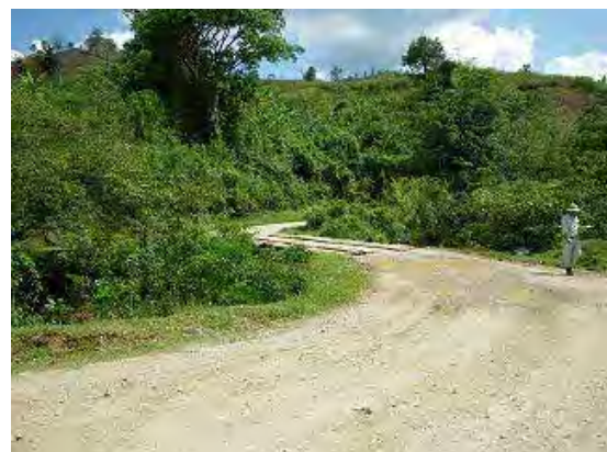
Fotografía 1a-4 Condición del acceso
