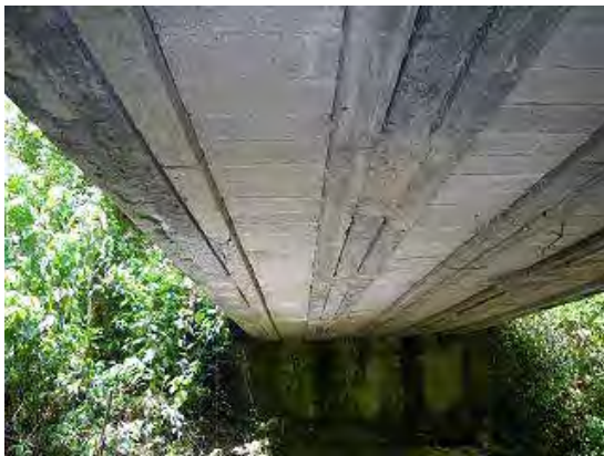
Fotografía 1a-3 Condición bajo las viguetas
