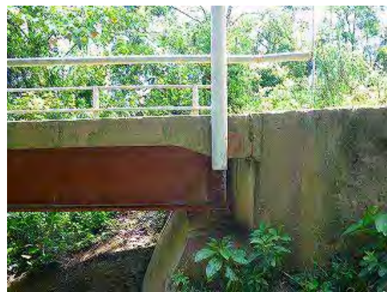
Fotografía 1a-4 Conexión entre vigas y estribo
