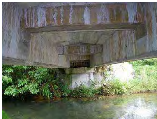
Fotografía1a-3 Condición bajo las vigas
