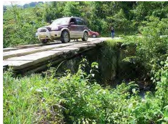
Fotografía 1a-2 Vista lateral del puente
