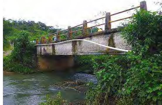
Fotograf1a-2 Vista lateral del puente
