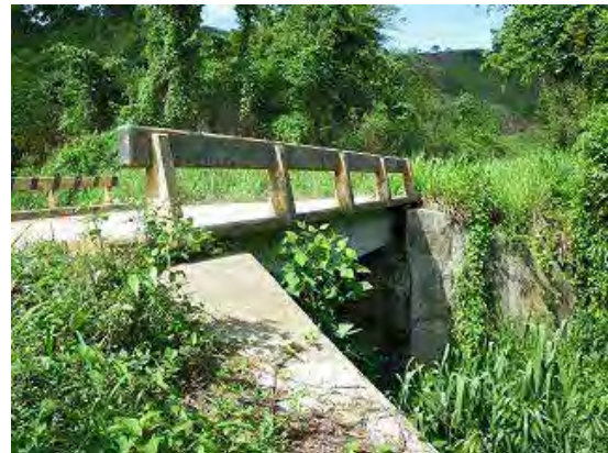
Fotografía1a-2 Vista lateral del puente
