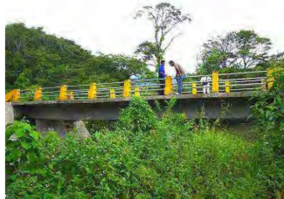
Fotografía-2 Vista lateral del puente
