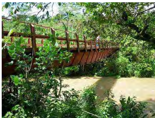
Fotografía1a-3 Vista lateral del puente
