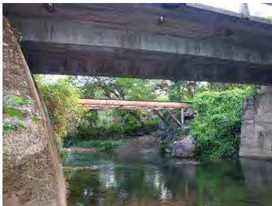
Fotografía 1a-3 Condición bajo el puente
