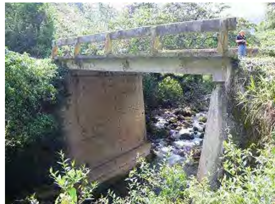
Fotografía 1a-2 Vista lateral del puente
