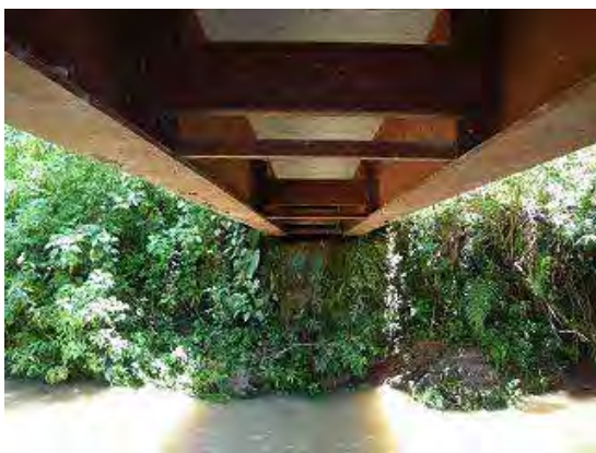
Fotografía 1a-3 Condición bajo las vigas
