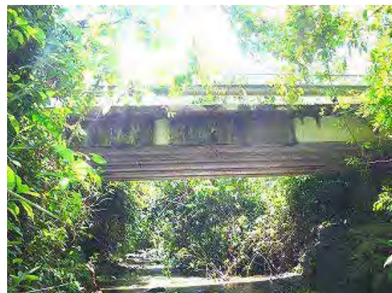
Fotografía 1a-2 Vista lateral del puente
