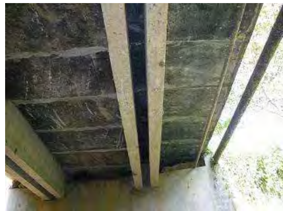
Fotografía-4 Condición abajo del puente
