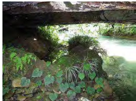
Fotografía 1a-2 Condición del soporte de la infraestructura
