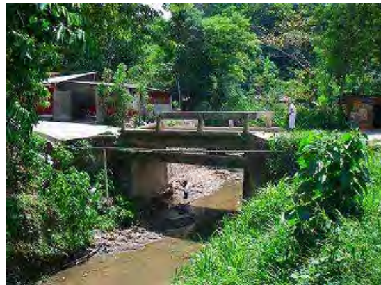
Fotografía 1a-2 Vista lateral del puente
