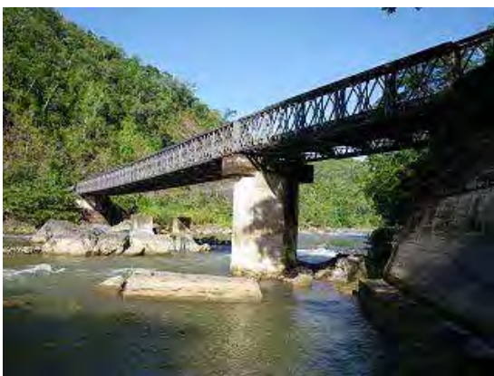
Fotografía-3 Vista lateral del puente
