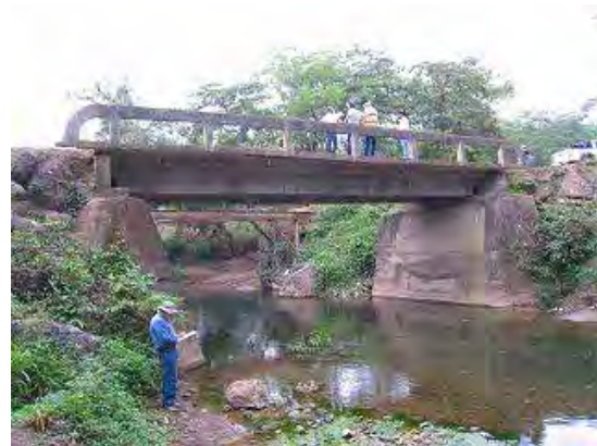
Fotografía 1a-2 Vista lateral del puente
