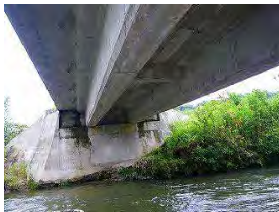
Fotografía-3 Condición bajo las vigas
