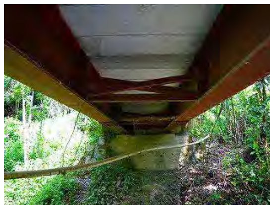
Fotografía 1a-3 Condición de vigas
