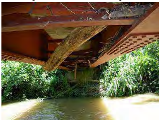
Fotografía 1a-3 Condición bajo las vigas
