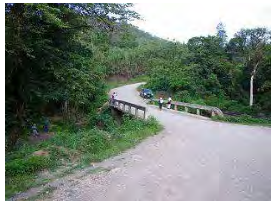
Fotografía 1a-4 Condición del acceso al puente
