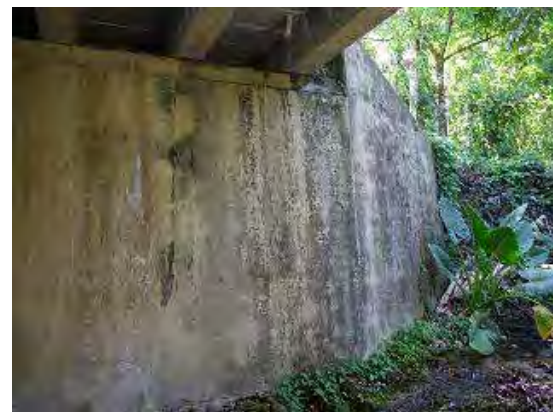
Fotografía1a-4 Condición del estribo
