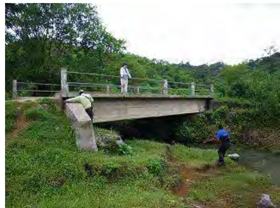
Fotografía 1a-2 Vista lateral del puente
