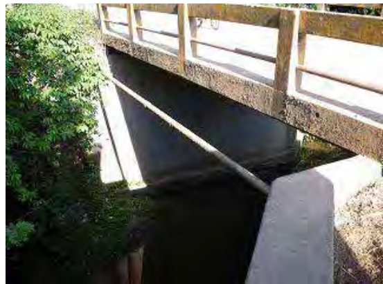
Fotografía-2 Vista lateral del puente (1)
