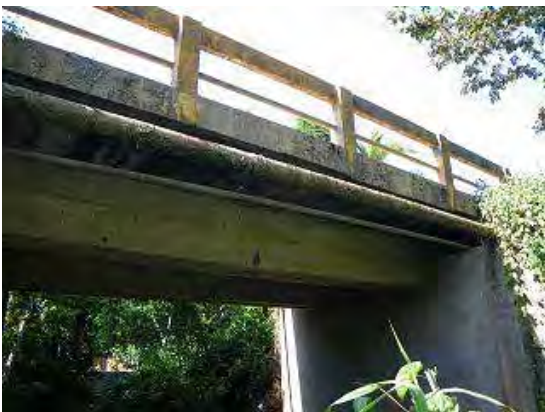
Fotografía-3 Vista lateral del puente (2)
