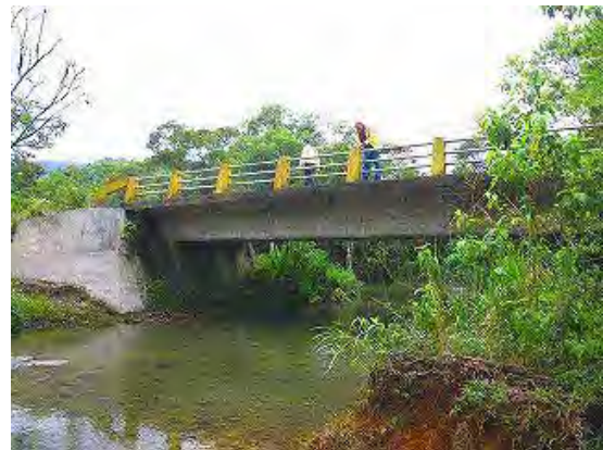
Fotografía1a-2 Vista lateral del puente
