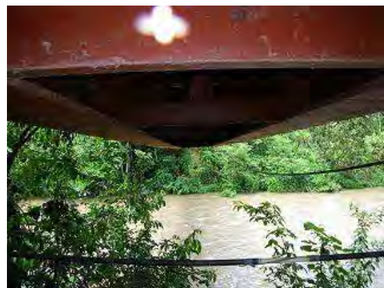
Fotografía1a-4 Condición bajo las vigas
