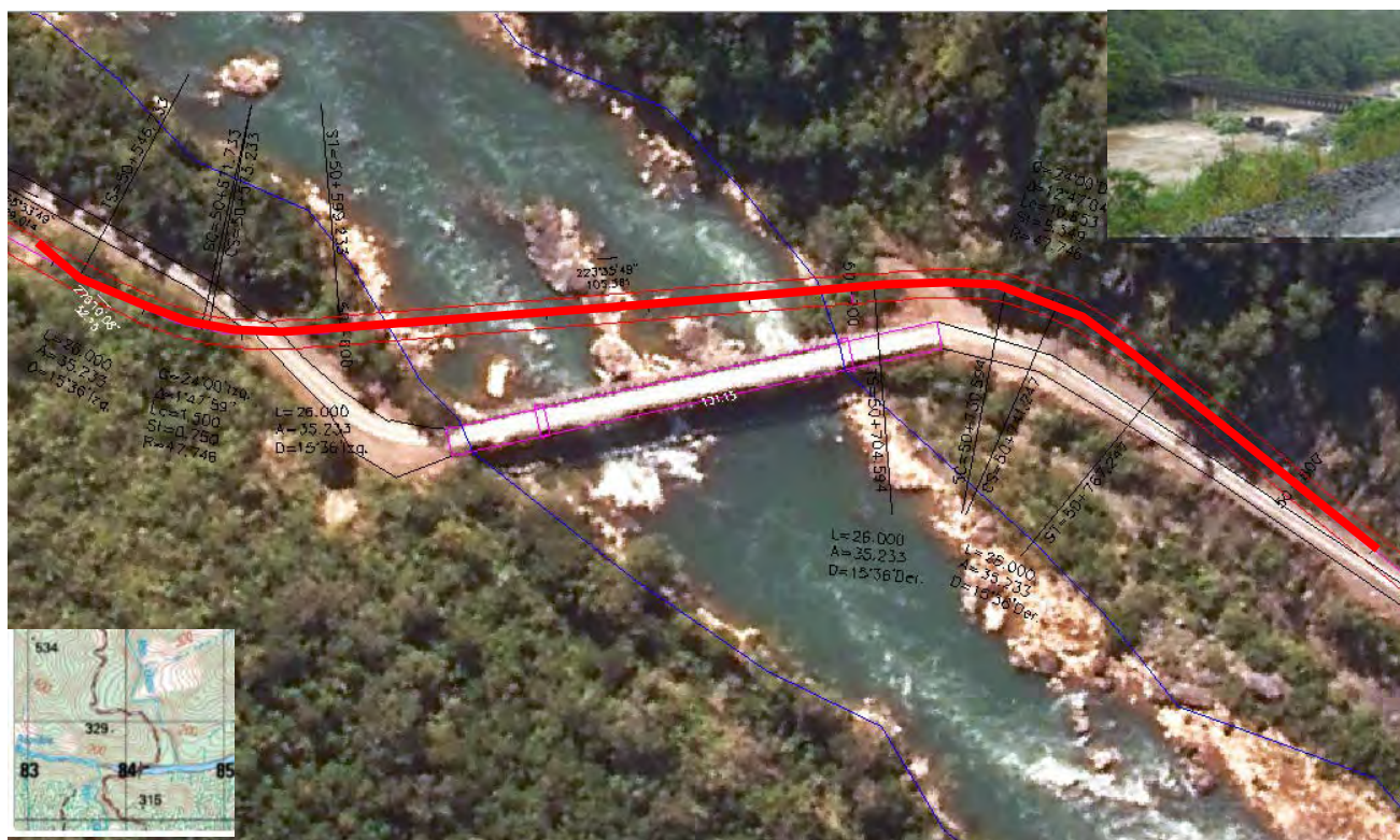
図7-34 ランキン〜ラ・ソレダッド間の線形変更箇所 (カーボン橋)
