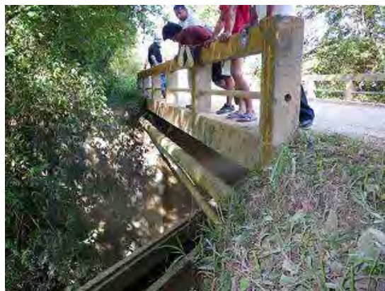
写真-2 橋梁側面状況
