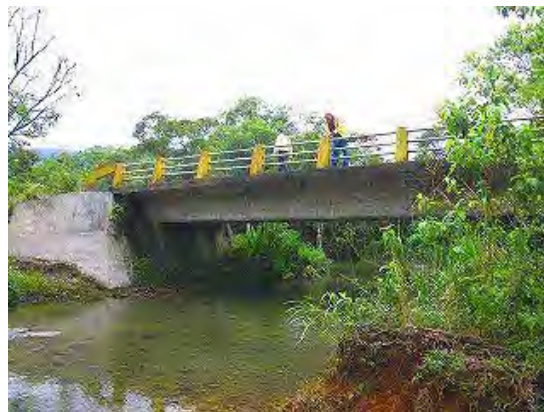
写真-2 橋梁側面状況
