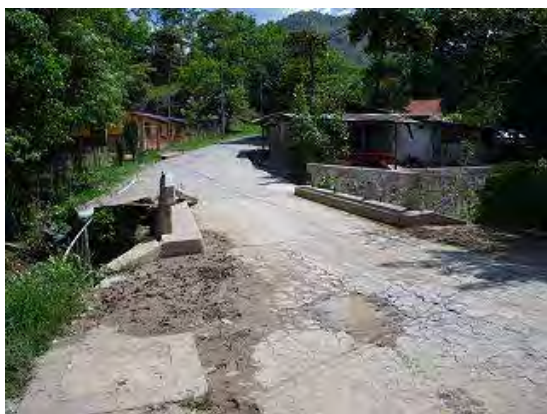
写真-1 橋面状況
