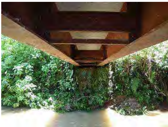
写真-3 桁下面状況
