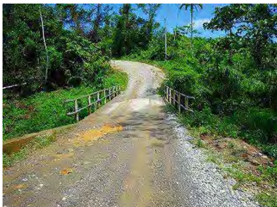
写真-1 橋面状況
