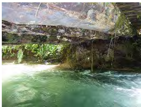
写真-3 橋梁下面状況
