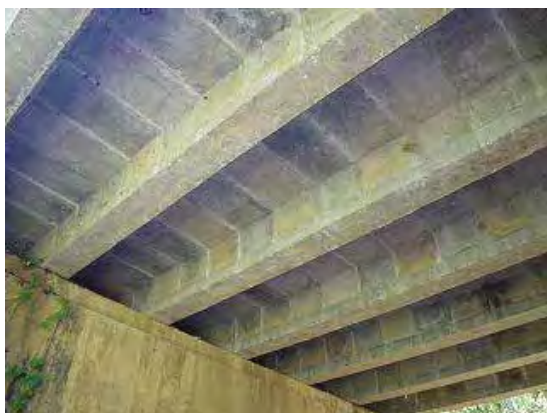
写真-3 橋梁下面状況
