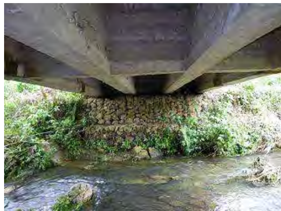
写真-3 橋梁下面状況と橋台全面の布団籠
