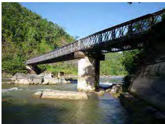
写真-3 橋梁側面状況
