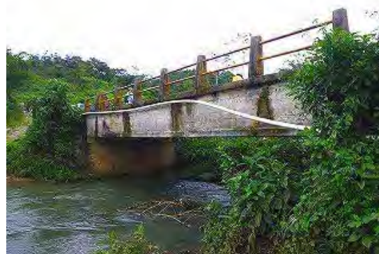
写真-2 橋梁側面状況
