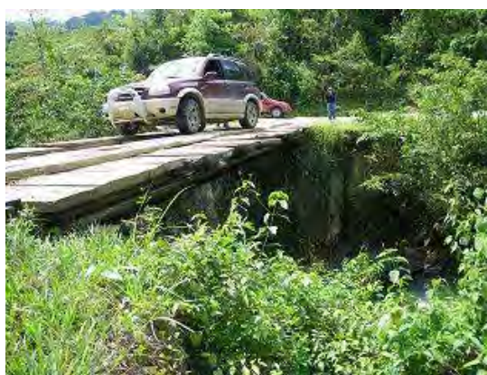
写真-2 橋梁側面状況
