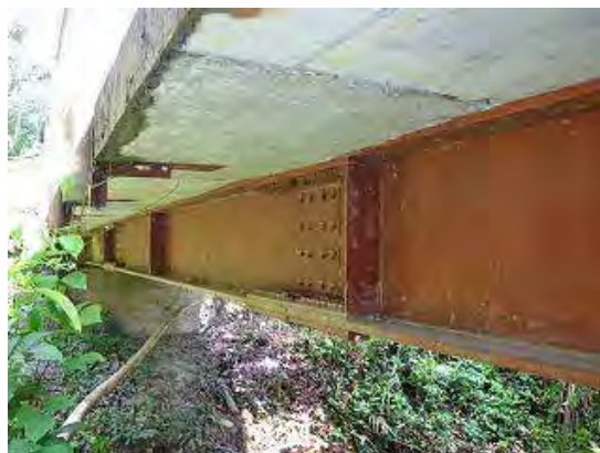
写真-2 主桁（鋼桁）状況
