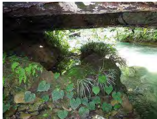
写真-2 上部構造支持状況
