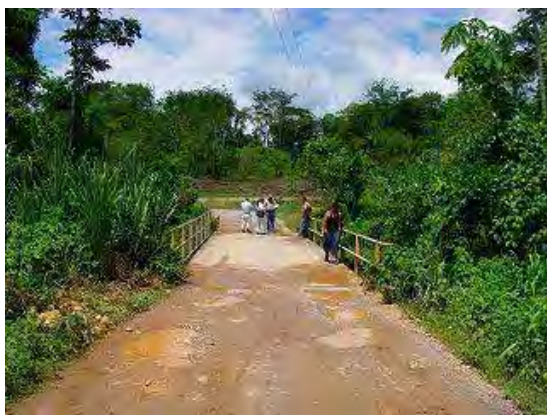
写真-1 橋面状況
