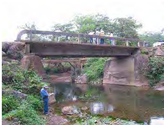
写真-2 橋梁側面状況
