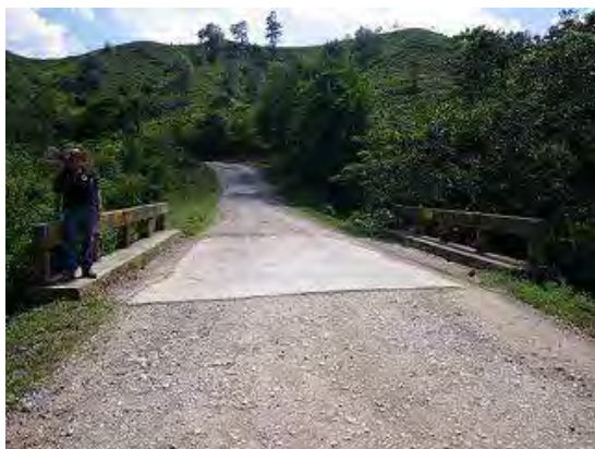
写真-1 橋面状況
