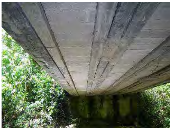
写真-3 橋梁下面状況
