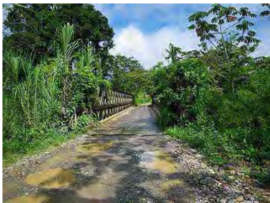
写真-1 橋面状況(1)
