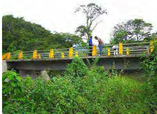
写真-2 橋梁側面状況
