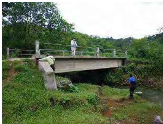
写真-2 橋梁側面状況
