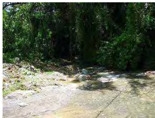
写真-2 下流側状況
