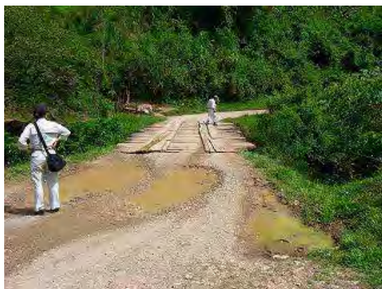
写真-1 橋面状況
