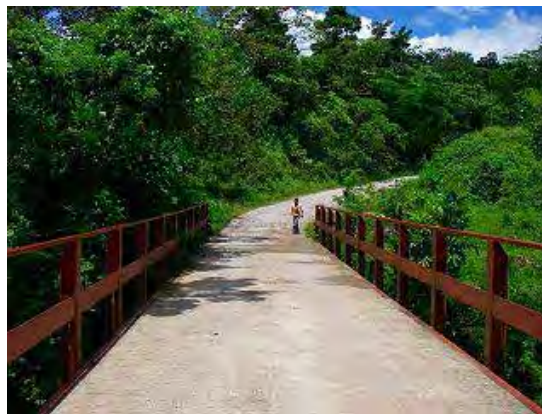
写真-2 橋面状況(2)
