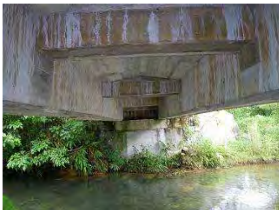
写真-3 橋梁下面状況
