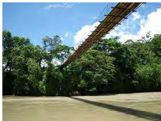
写真-3 橋梁下面状況
