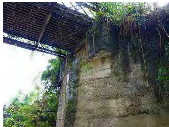
写真-4 下部構造状況
