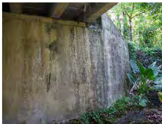
写真-4 下部構造状況
