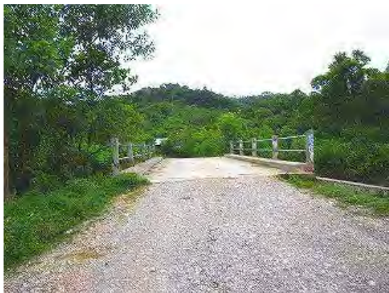
写真-1 橋面状況
