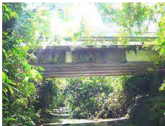
写真-2 橋梁側面状況
