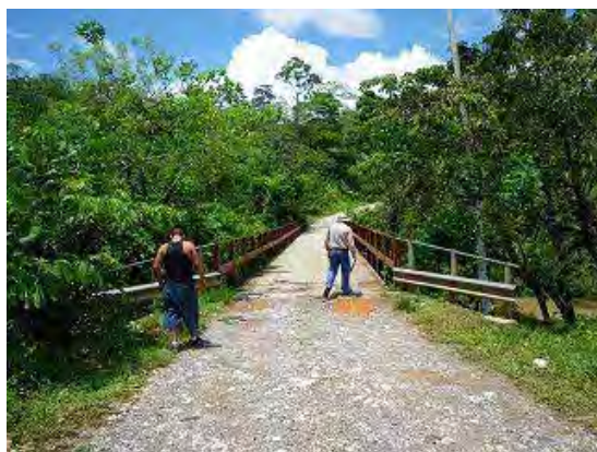
写真-1 橋面状況(1)
