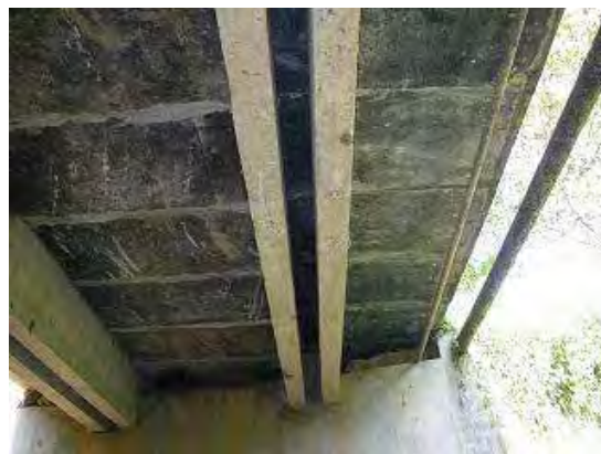
写真-4 橋梁下面状況
