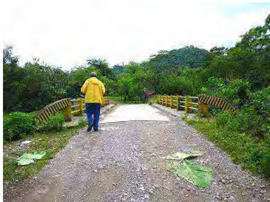
写真-1 橋面状況
