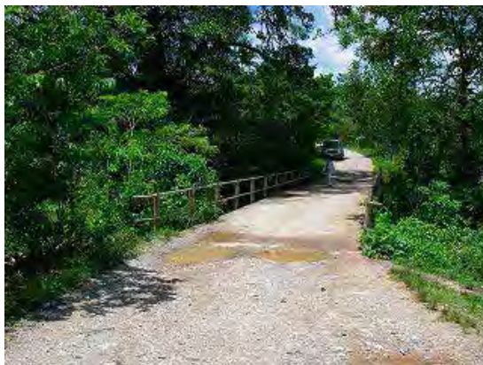
写真-1 橋面状況
