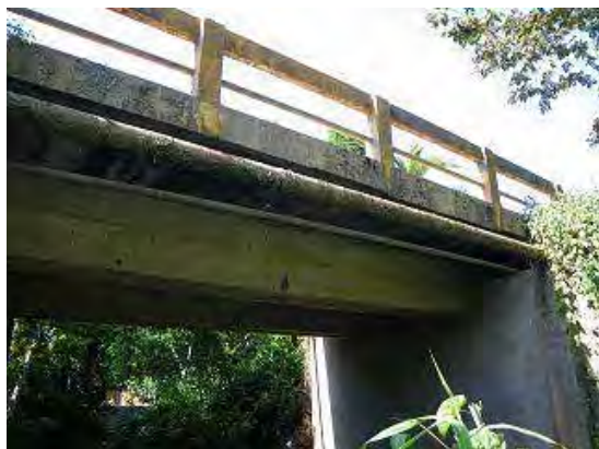
写真-3 橋梁側面状況 (2)
