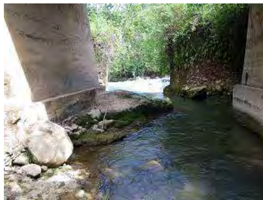
写真-4 橋台および河床状況
