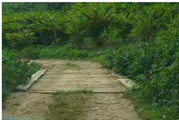
写真-1 橋面状況
