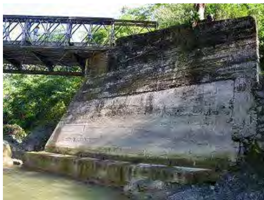
写真-4 橋台状況
