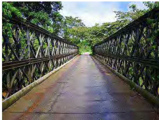
写真-2 橋面状況(2)
