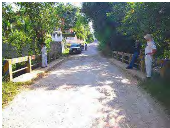
写真-1 橋面状況
