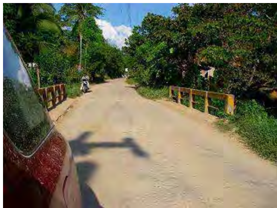
写真-1 橋面状況
