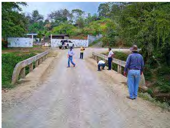
写真-1 橋面状況
