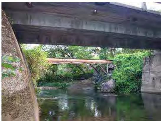
写真-3 桁側面および河床状況
