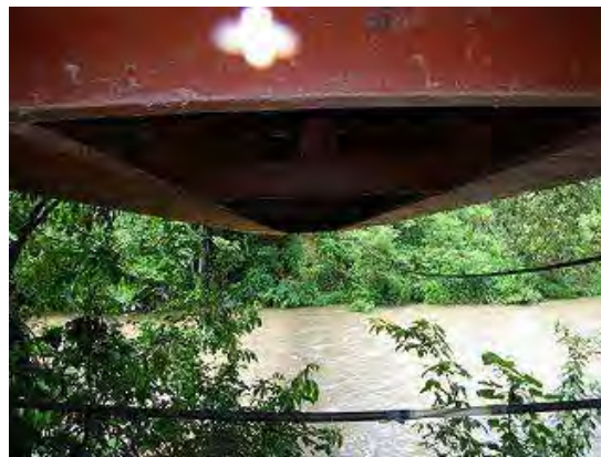
写真-4 桁下面状況
