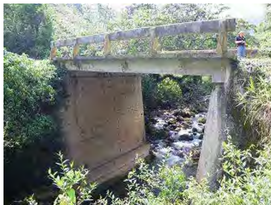
写真-2 橋梁側面状況
