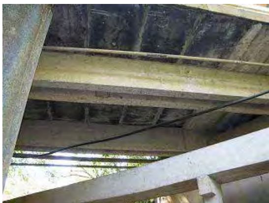
写真-3 橋梁下面状況
