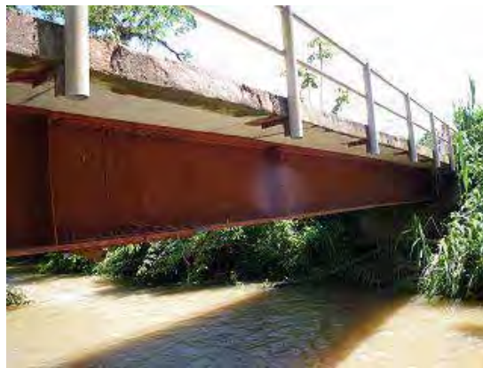
写真-2 主桁(鋼桁)状況
