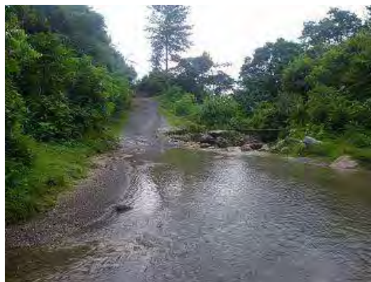
写真-2 河川状況
