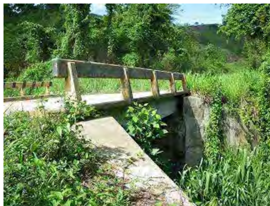
写真-2 橋梁側面状況
