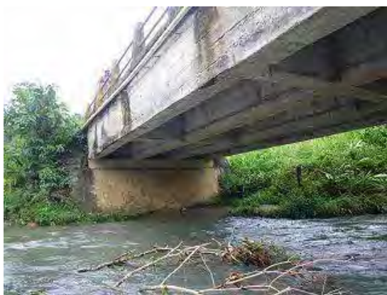
写真-3 橋梁下面状況
