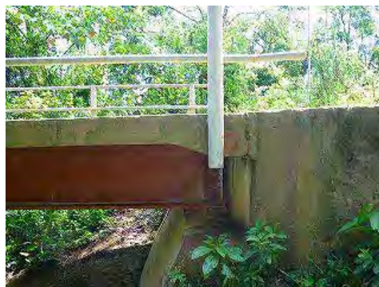
写真-4 橋台との取り付け状況
