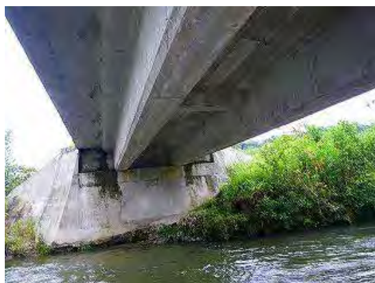
写真-3 橋梁下面状況
