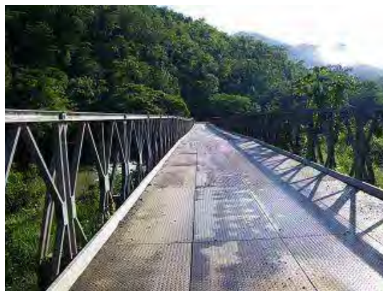
写真-2 橋面状況
