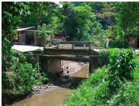
写真-2 橋梁側面状況
