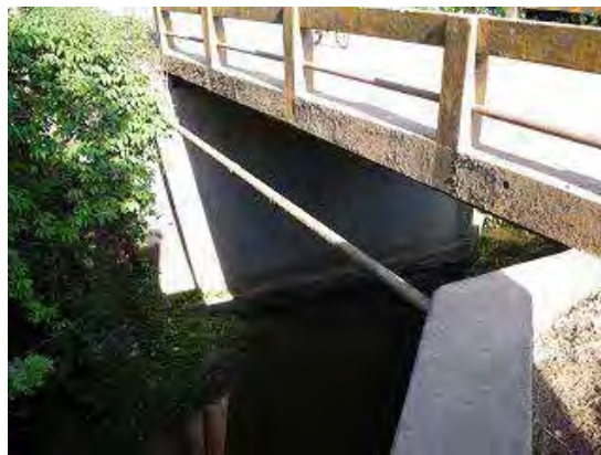
写真-2 橋梁側面状況 (1)
