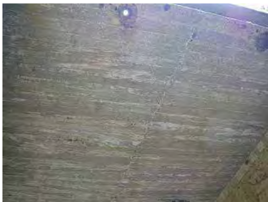
写真-3 橋梁下面状況
