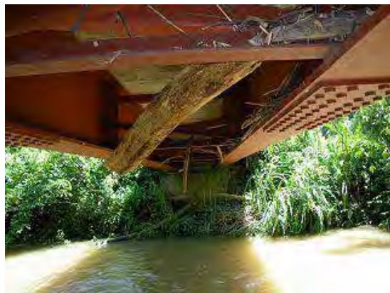
写真-3 桁下面状況
