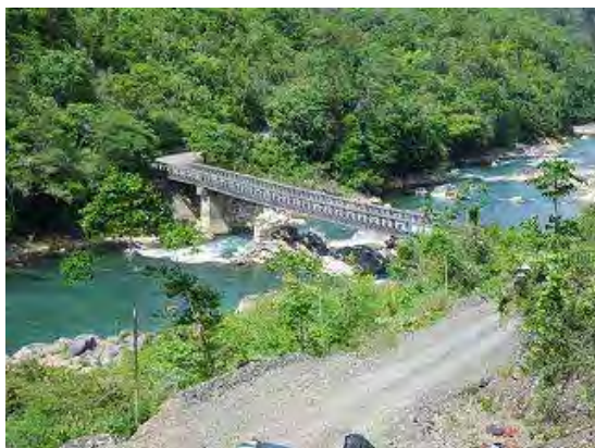
写真-1 橋梁全景
