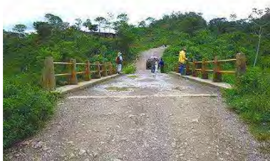
写真-1 橋面状況
