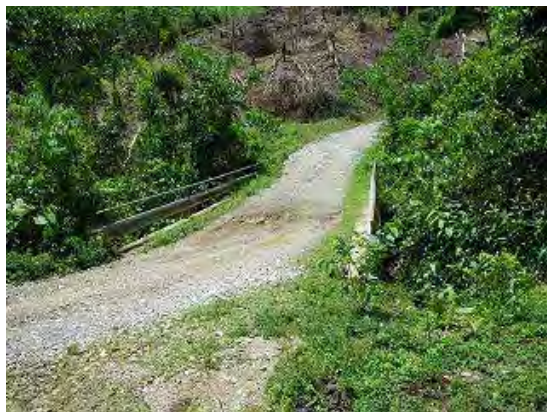
写真-1 橋面状況
