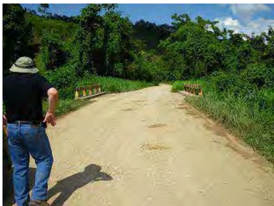
写真-1 橋面状況
