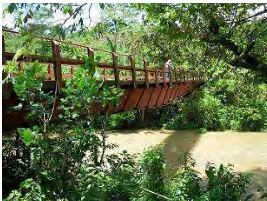
写真-3 橋梁側面状況
