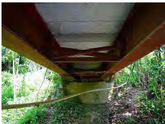
写真-3 桁下面状況
