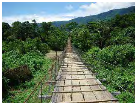
写真-2 橋面状況
