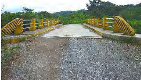
写真-1 橋面状況
