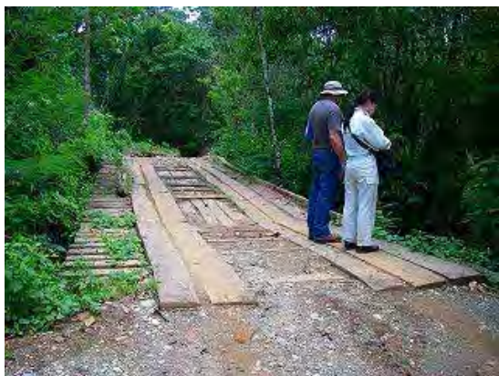
写真-1 橋面状況
