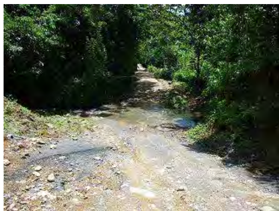
写真-1 現道と河川交差部状況
