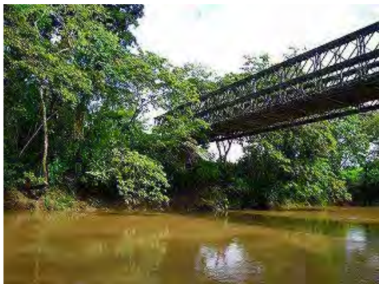
写真-3 橋梁側面
