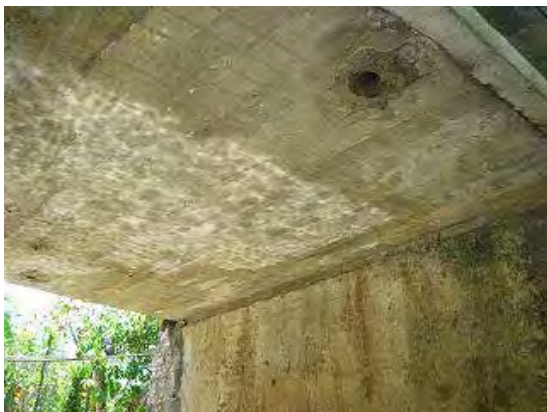
写真-3 橋梁下面状況
