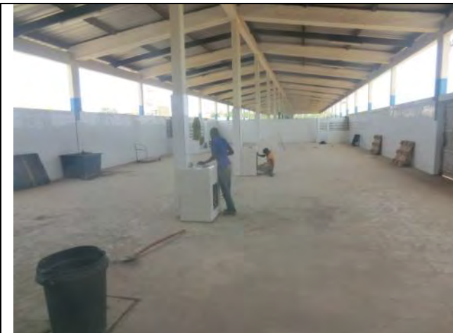
ンブール水揚場: GIE の独自資金により底魚の水揚エリアの改修(排水、足洗場、手洗シンク、タイル張り等)が進行中である。
