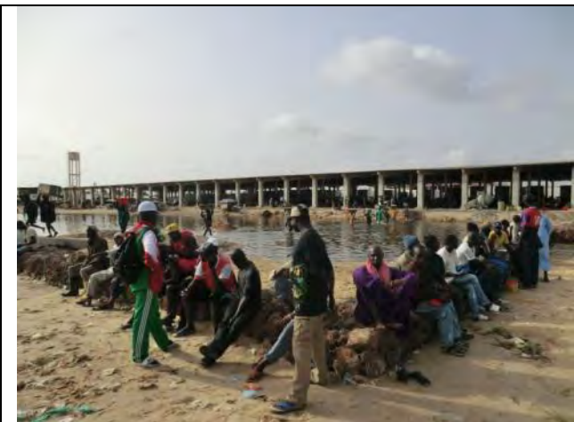
ジョール水揚場: 気象変動基金による前浜の護岸整備が進捗中であるが埋立工事は GIE 負担となっているため潮が滞留して不潔な状態となっている。
