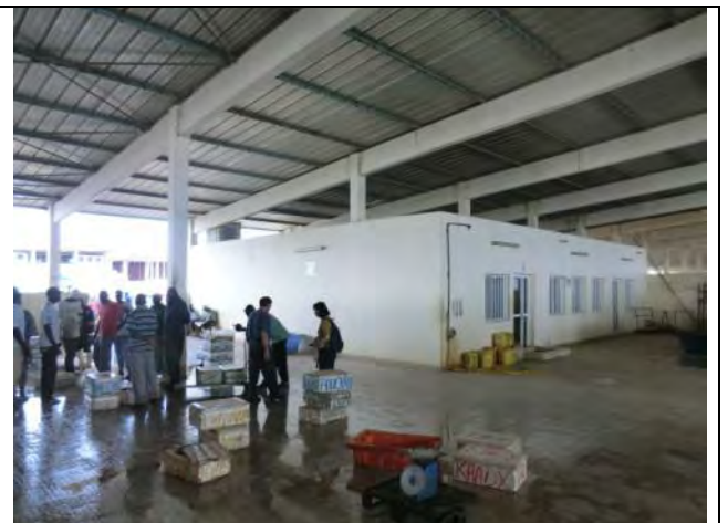
ジョール水揚場: 既存建屋内に EU 支援による検査・加工施設が整備され、GIE により隣接する底魚水揚エリアは壁で区画しタイル張りに改修されている。
