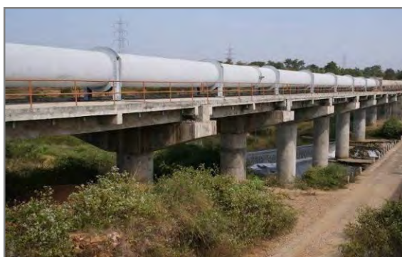
バンガロール市への送水管
