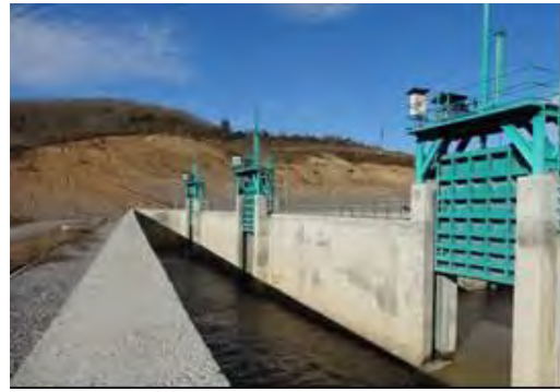
シレコントロールセンター
