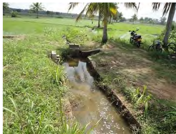
本事業で農民により改修され、現在も農民が維持管理している灌漑水路 (北中部州アヌラーダプラ県)
