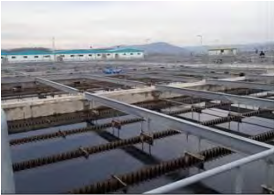
ジュームフリエット浄水場
