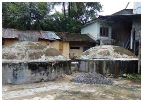
本事業の融資を利用して整備された 精米工場の廃水処理施設
