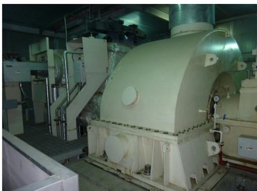
写真 3：ガスタービン発電設備
