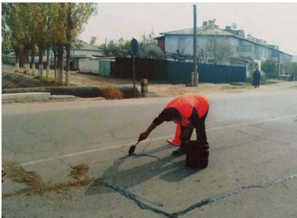
路面クラックにシーリング補修をしている様子
