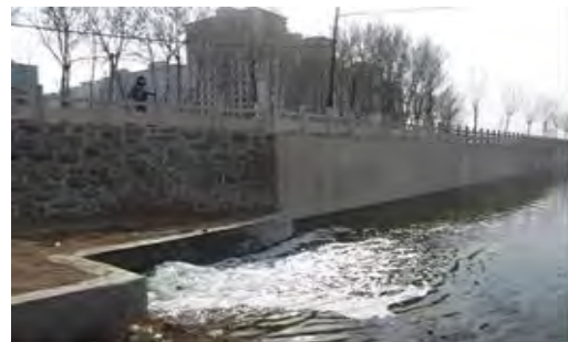
小黒河の支流に放流される 公主府下水処理場の処理水
