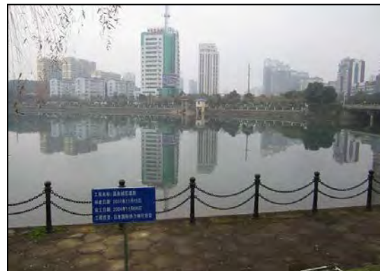
本事業で整備された淦河急流の堤防
