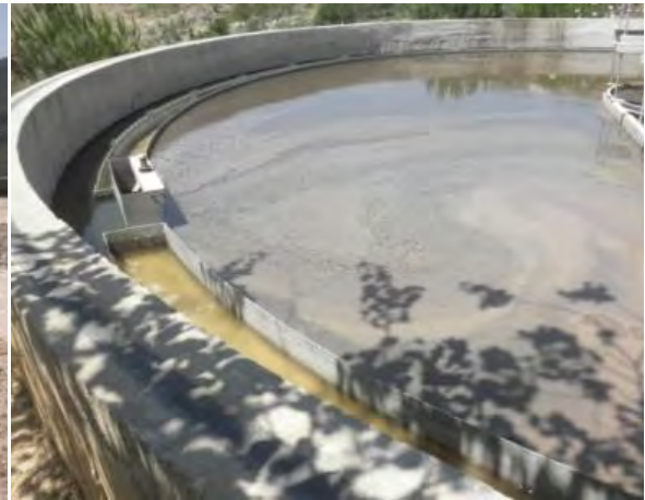
同処理場最終沈殿池 (2016.6.18)
