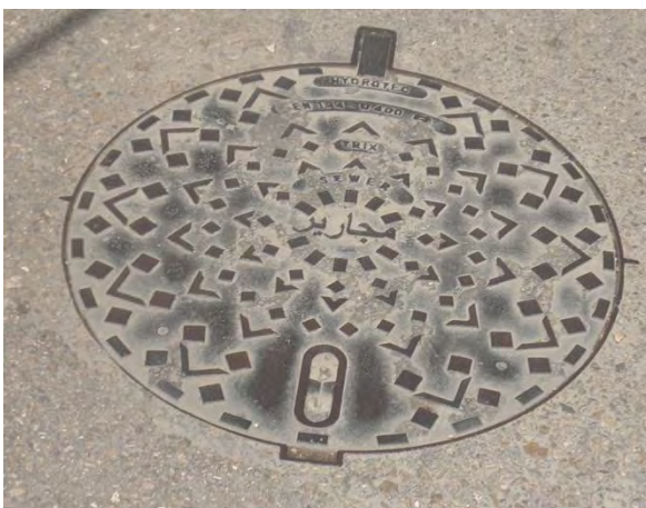
ベイルート市内の汚水マンホール (2016.6.24)
