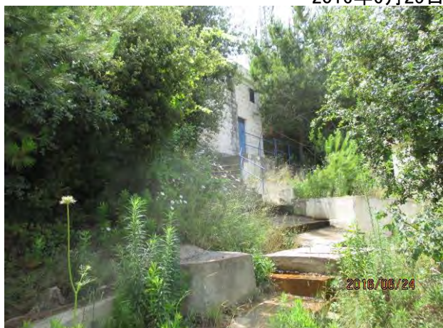
高所配水池 in Ghadir Area 容量は不明(5,000m 3 ) 半地上式鉄筋コンクリート Jounie Municipality in Kesrouan District
