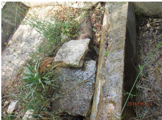
高所配水池 in Ghadir Area 流入管 \phi 100mm DIPで接合部ゴムから漏水 Jounie Municipality in Kesrouan District
