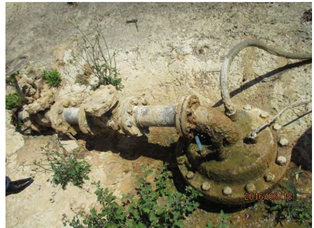
中継ポンプ所と配水池 下側に10m 3 程度の水槽があり、水中ポンプで揚水
