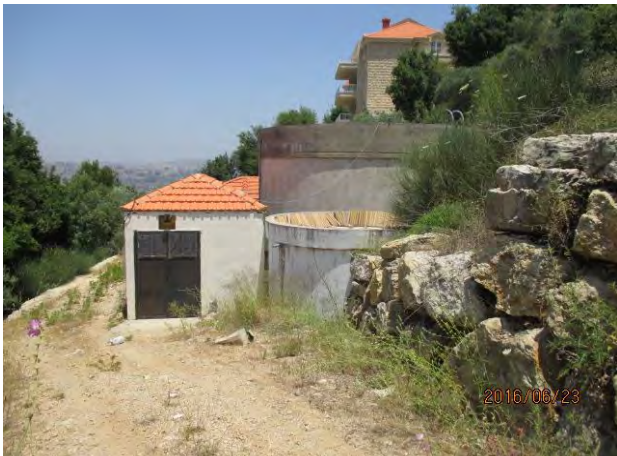
配水池(奥400m 3 +手前50m 3 程度)、手前は制御建屋 Aamatour in Aley District
