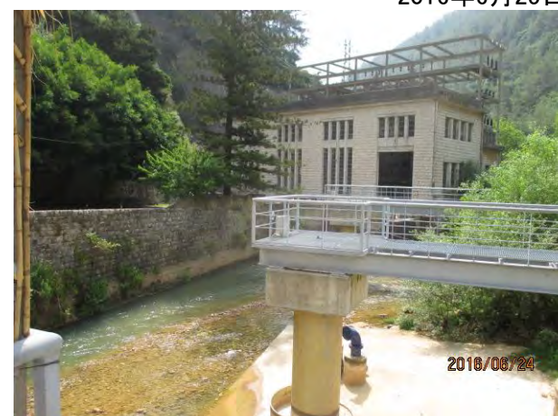
14km北北東にあるJdeidetの水源(Bizhel) 堰の上流から伏流水を取水 Bizhel in Kesrouan District 2016年6月25日
