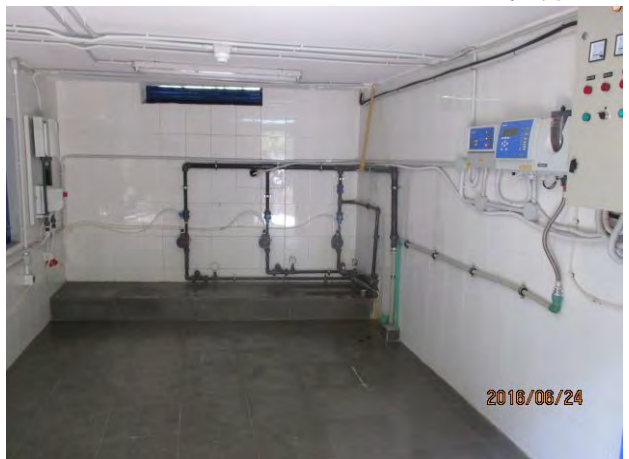
14km北北東にあるJdeidetの水源(Bizhel) 塩素ガス注入装置
