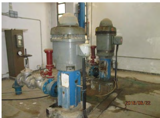
Mhattet ポンプ場 高所住宅地にポンプアップしていた。現在未使用 Mhattet in Aley district
