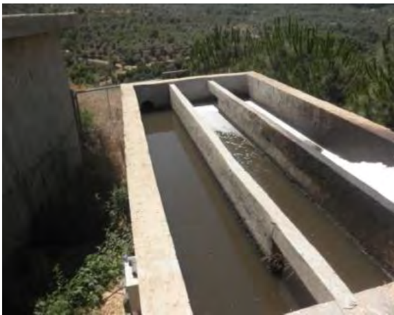
同処理場塩素混和池 (2016.6.18)
