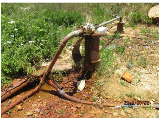
Btaterの水源 写真奥が深井戸、手前が失敗井を利用した中間貯水池 井戸深度420m、10L/s ? Btater Municipality in Aley District
