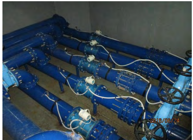
14km北北東にあるJdeidetの水源(Bizhel) 流量計測
