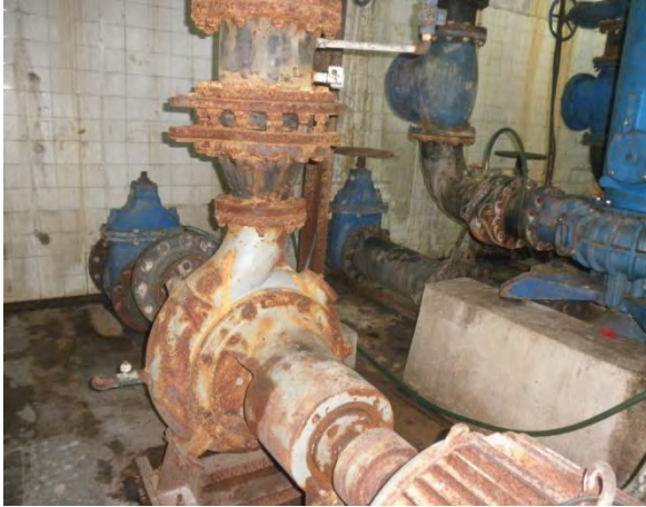
内 1 台の状況 (完全に故障し取り替えが必要) (2016.6.24)
