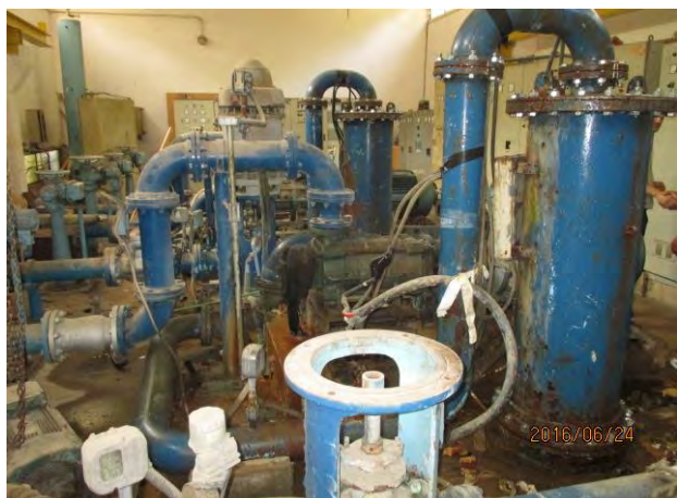
Hautauch ポンプステーション 5台中3台稼働(2台縦型、1台横型)、220KW Jounie Municipality in Kesrouan District
