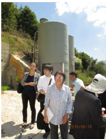
中継ポンプ所と配水池 20m 3 の配水池
