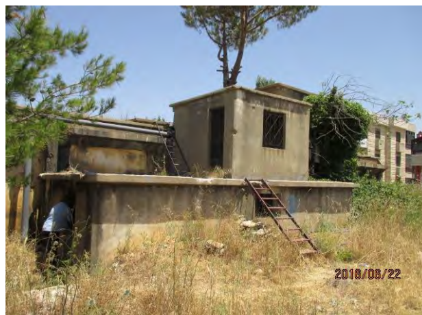
Aleyの5,000m 3 配水池(56年経過) 配水池からの配水網への分水 Aley in Aley district
