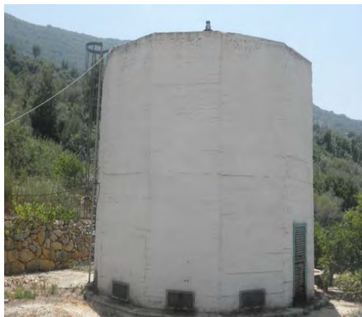
Ammatour Municipality in Alay District の処理場散水ろ床施設 ( 処理水量 900m 3 /日、処理人口 9,000 人、 2007 竣工 ) (2016.6.23)
