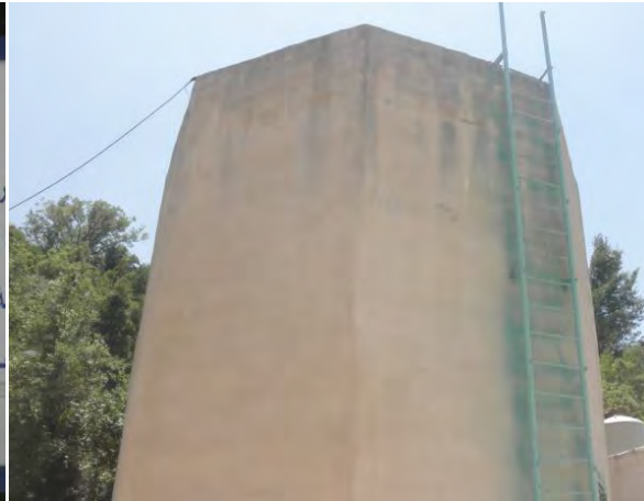
同処理場の散水ろ床施設 ( 処理水量 450m 3 /日、処理人口 3,000 人、 2007 年竣工 ) (2016.6.23)
