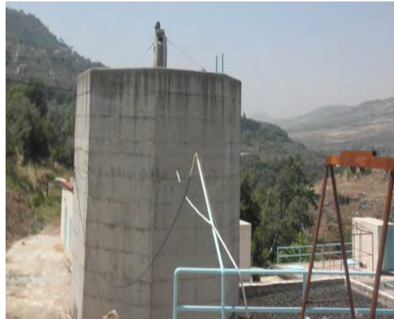
同処理場の散水ろ床施設 ( 処理水量 450m 3 /日、処理人口 3,000 人、 2007 年竣工 ) (2016.6.23)
