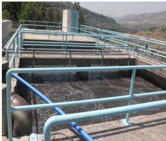
同処理場の曝気施設 (2016.6.23)
