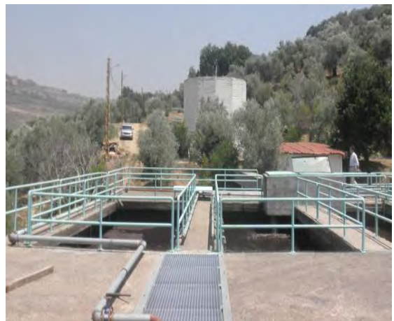
同処理場の汚泥天日乾燥床 (2016.6.23)
