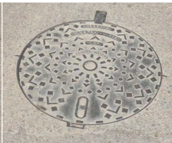
ベイルート市雨水マンホール (2016.6.24)
