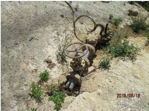
中継ポンプ所と配水池 下側に10m 3 程度の水槽があり、水中ポンプで揚水している
