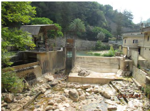
14km北北東にあるJdeidetの水源(Bizhel) 1996年の円借で建設 Jbail郡とKesrouan郡の郡境界を流れるIbrahim川 2016年6月25日
