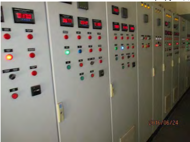
14km北北東にあるJdeidetの水源(Bizhel) 制御盤
