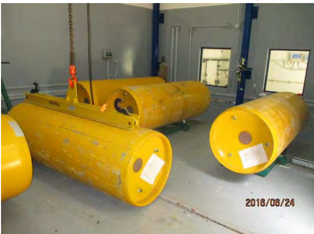
14km北北東にあるJdeidetの水源(Bizhel) 塩素ガス注入(インド製)
