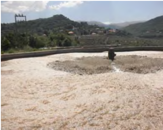
同処理場表面曝気槽 (2016.6.18)
