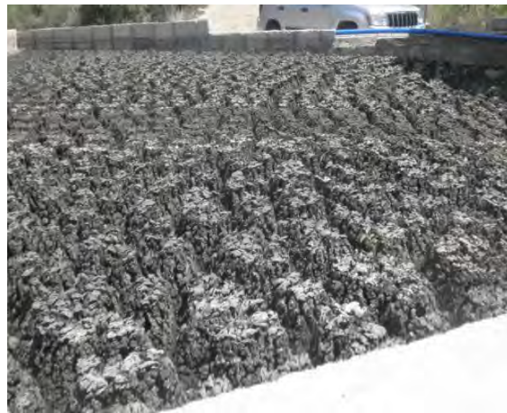
同処理場の汚泥天日乾燥床 (2016.6.23)
