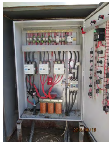
中継ポンプ所と配水池 制御盤:リレースイッチ故障
