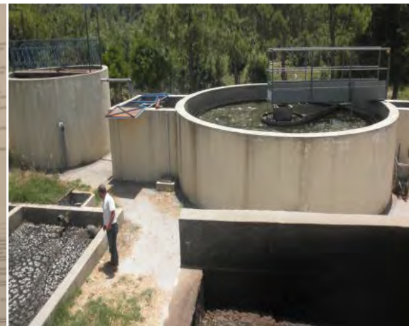
同処理場施設配置 (処理水量 450m 3 /日、処理人口 3,000 人、 2007 年竣工) (2016.6.23)
