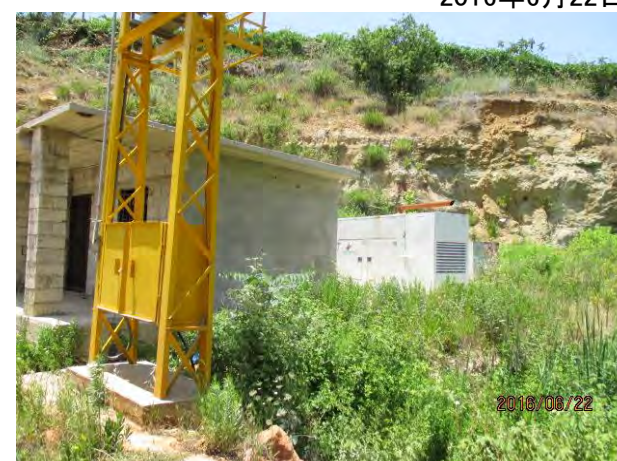
Btaterの制御盤室と発電機 建物内に制御盤、奥に発電機 Btater Municipality in Aley District
