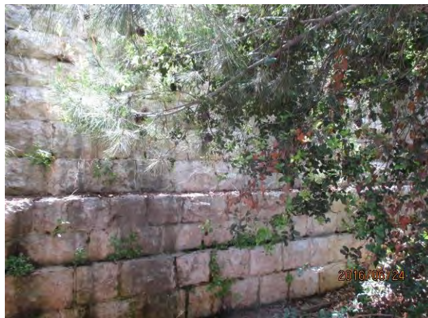
高所配水池 in Ghadir Area 半地上式鉄筋コンクリート 壁表面は石積 Jounie Municipality in Kesrouan District
