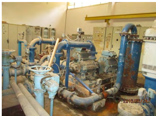
Hautauch ポンプステーション 5台中2台故障(奥2台横型) Jounie Municipality in Kesrouan District
