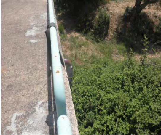
同処理場処理水放流地点 (鼠色の樋から放流) (2016.6.23)
