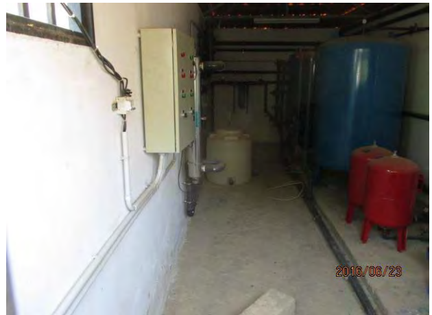
制御盤と塩素注入器
