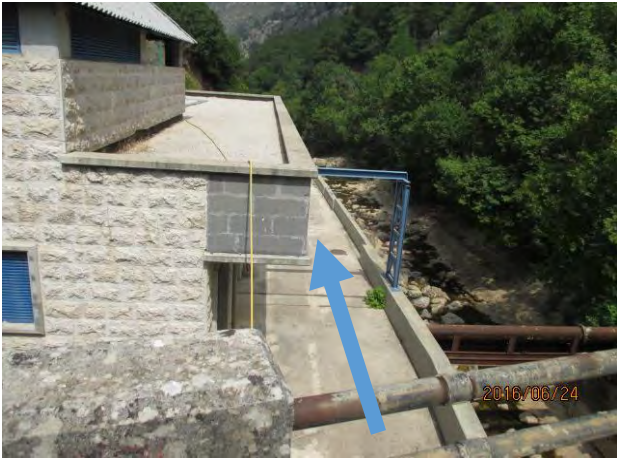
14km北北東にあるJdeidetの水源(Bizhel) 送水管(φ800mm?) コンクリートスラブ下 Bizhel in Kesrouan District
