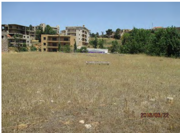
Aleyの5,000m 3 配水池(56年経過) 配水池屋上 Aley in Aley district
