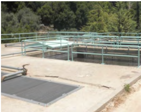
同処理場曝気槽 (2016.6.23)
