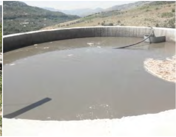
同処理場最初沈殿槽 (2016.6.18)
