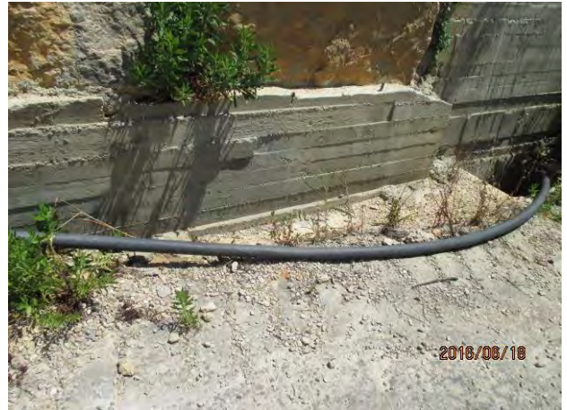
中継ポンプ所と配水池 配水池周りの配管状況(HDPE pipe)
