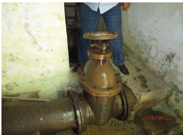
Mhattet 分水場 (広域送水網からの分水) φ400mmから分水されている Mhattet in Aley district
