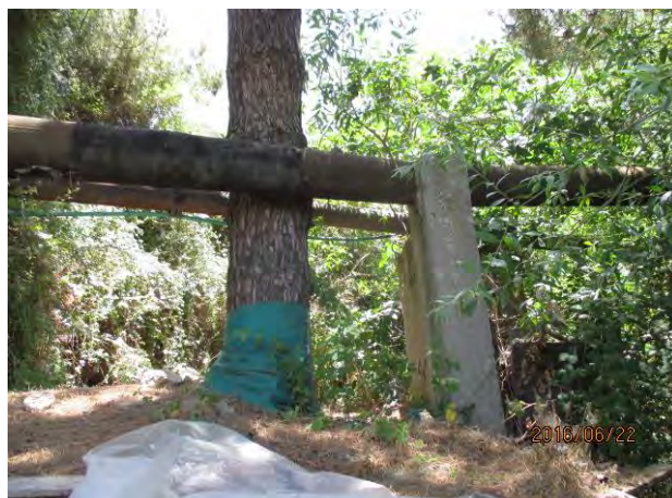
Mhattet 分水場 (広域送水網からの分水) 配管状況 Mhattet in Aley district
