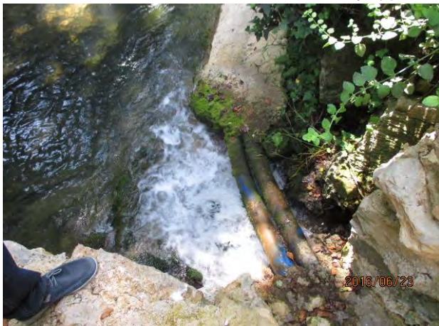
湧水場所からの導水管(φ50mm×2)
