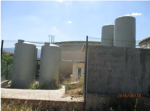
高所にある配水池(2,000m 3 +60m 3 )
