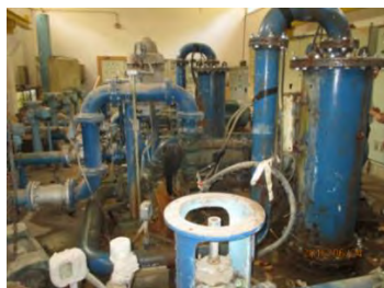
Hautauch ポンプステーション 5台中3台稼働（2台縦型、1台横型）、220KW Jounie Municipality in Kesrouan District 2016年6月25日
