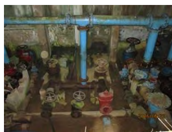
Aley の 5,000m 3 配水池（56年経過） 配水池からの配水網への分水 Aley in Aley district 2016年6月22日
