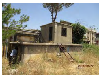
Aley の 5,000m 3 配水池（56年経過） 半地上式鉄筋コンクリート Aley in Aley district 2016年6月22日
