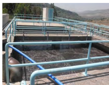
Moukhtara 処理場（計画水量 450m 3 /日、 2007年完成）内の曝気槽 2016年6月23日
