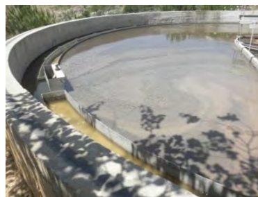
下水処理場最終沈殿池からの放流 Jdeidet El Chouf Municipality in Alay District 2016年6月18日
