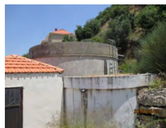
配水池（奥 400m 3 +手前 50m 3 程度） Aamatour in Aley District 2016年6月23日
