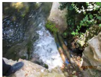
湧水場所からの導水管（φ50mm×2） Jdeidet El Chouf Municipality in Alay District 2016年6月23日
