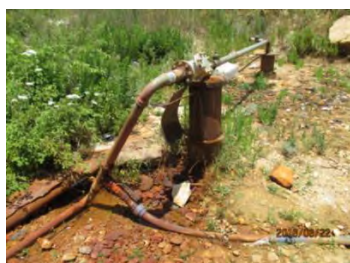
奥が深井戸、手前が失敗井利用中間貯水池 井 戸深度 420m、10L/s Btater Municipality in Aley District 2016年6月22日
