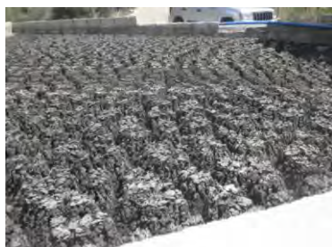
Moukhtara 処理場汚泥天日乾燥床 2016年6月23日
