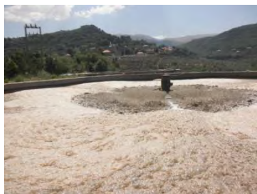
下水処理場表面曝気池 Jdeidet El Chouf Municipality in Alay District 2016年6月18日
