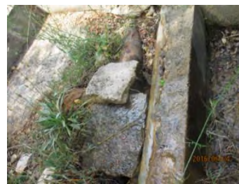
高所配水池 in Ghadir Area 流入管 φ100mm DIP でゴム接合部漏水 Jounie Municipality in Kesrouan District 2016年6月25日
