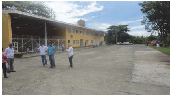
MAGELCO が所有している敷地
