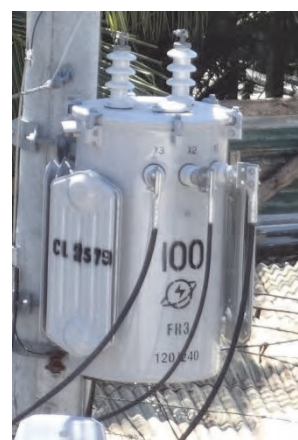
図 3-2.3 柱上変圧器
