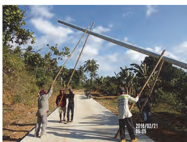
配電柱を建てる時(建柱)も人力作業にて行っている。
