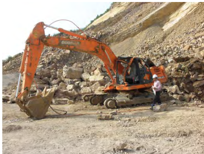
写真 No. 3 掘削機その 2
