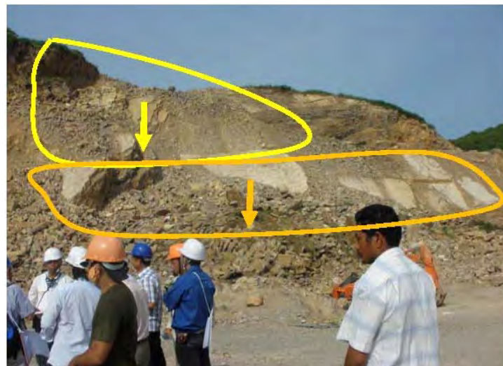
写真 NO. 5 第一次及び第二次岩盤崩壊の発生箇所
