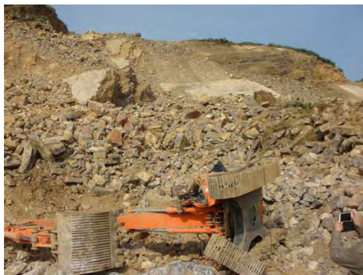
写真 No. 2 掘削機その 1
